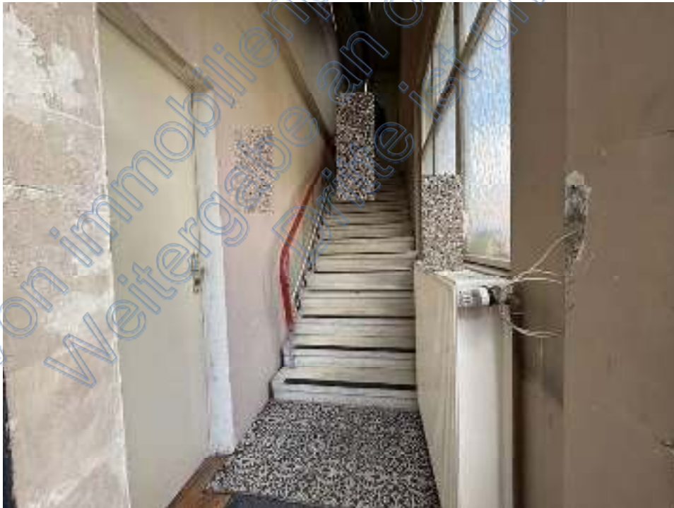
Bild 16 Eingang Treppenhaus Gewerbe
