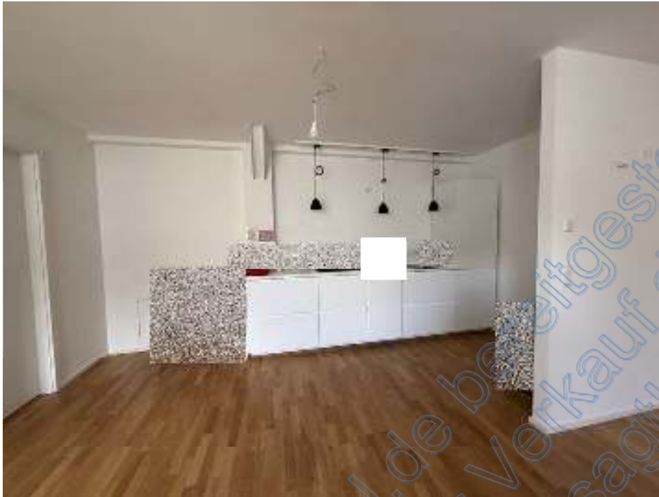
Gewerbeeinheit 1. Obergeschoss – Teeküche
