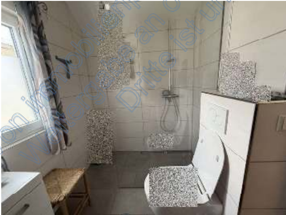
Wohnung im 1. Obergeschoss – Bad
