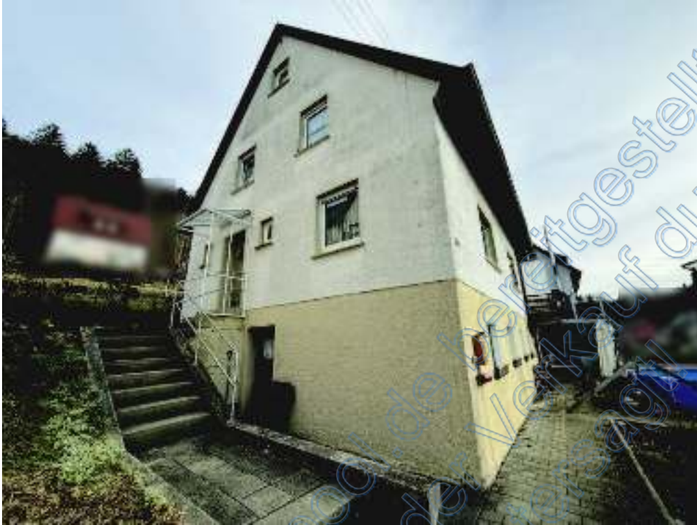
Bild 5 Uhlandstraße 58 – Eingang Untergeschoss und Eingang Erdgeschoss Risse und kleine Putzschäden, aufsteigende Feuchtigkeit
