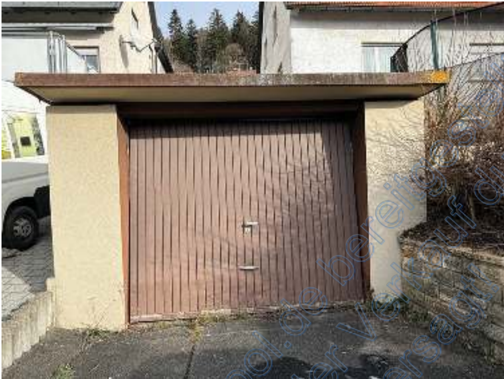
Bild 7 Uhlandstraße 58 – Garage nach Angabe nicht nutzbar
