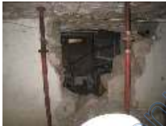
Mauerdurchbruch im EG
