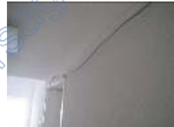
tlw. über Putz liegende Leitungen
