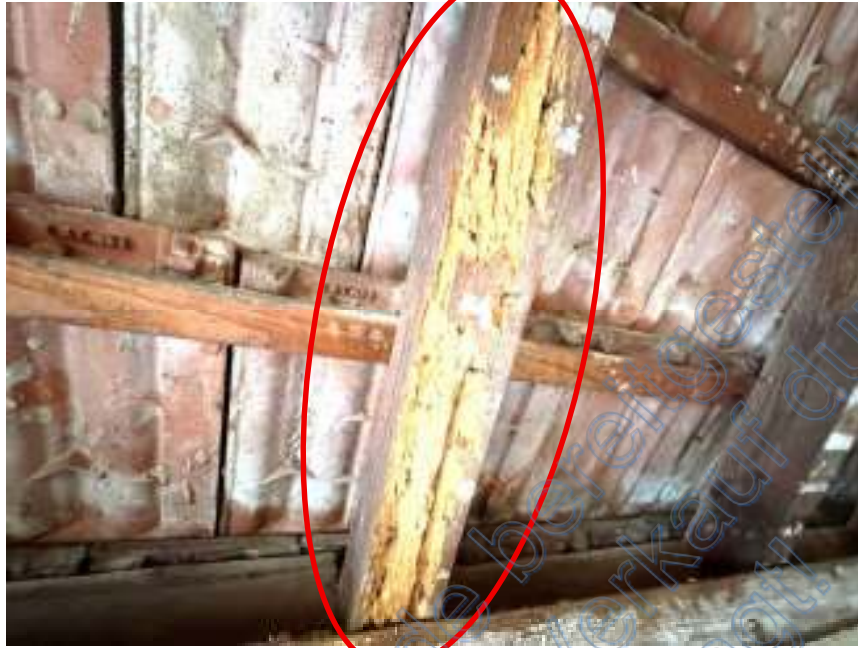
Bild 21: Schädlingsbefall im Gebälk der Veranda
