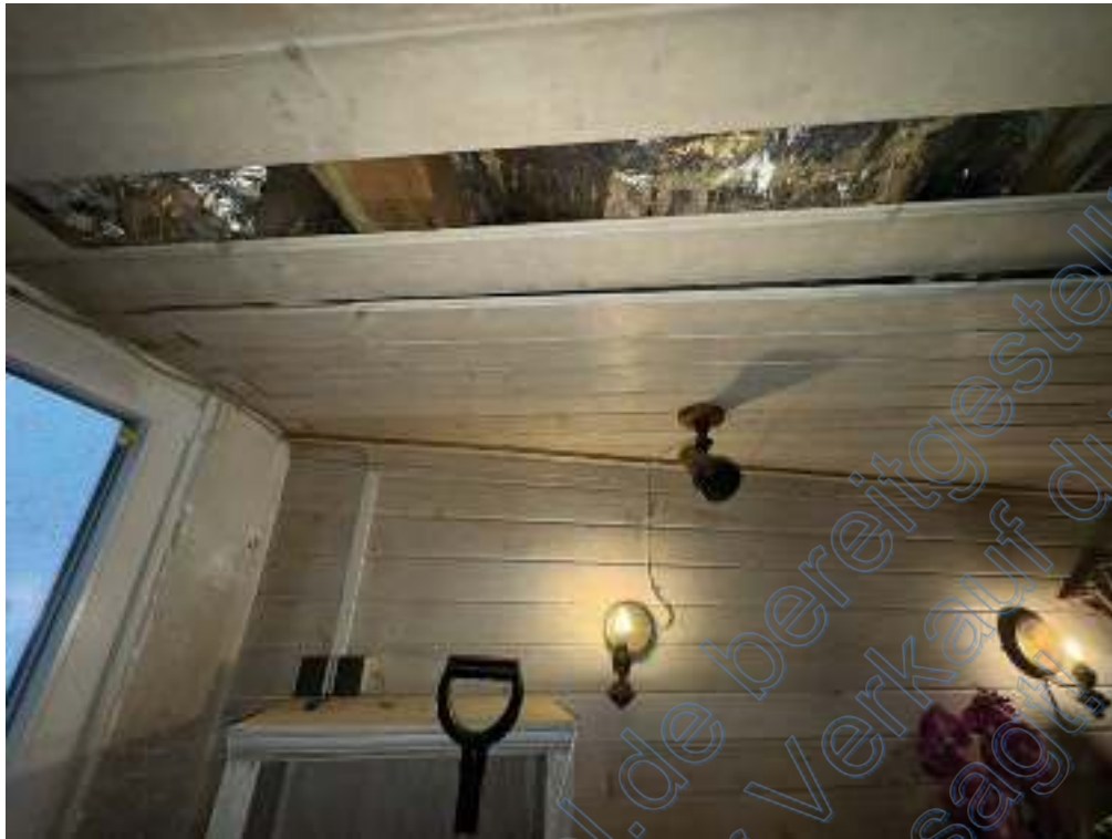
Erdgeschoss – Windfang Schaden an der Decke
