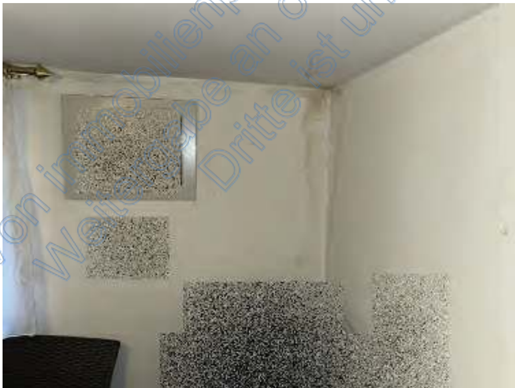
Erdgeschoss – Wohnraum mit weiterem Hinweis auf Feuchteschaden
