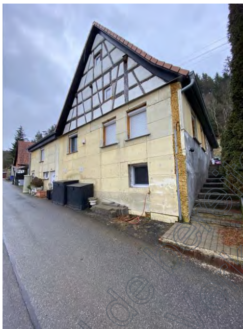
Bild 1: Nordseite mit Treppenaufgang zur Wohnung im Obergeschoss
