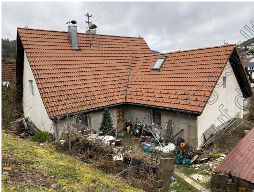
Bild 11: Südostseite mit Terrasse
