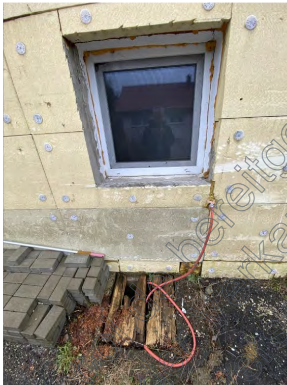
Bild 3: Dämmplatten an der Nordseite
