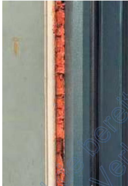
Bild 11: Detail mangelhaft eingebauter Haustüre
