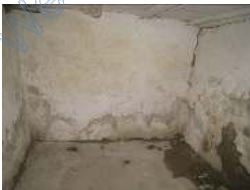
Innenansicht UG Kellerraum 1
