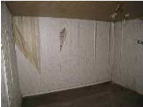
Innenansicht OG Zimmer 1
