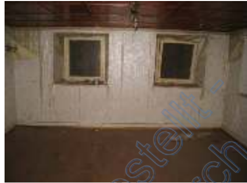
Innenansicht OG Zimmer 2
