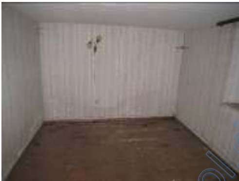
Innenansicht EG Zimmer 2
