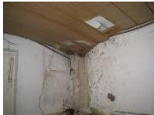
... mit Deckenbruch/Wasserschaden
