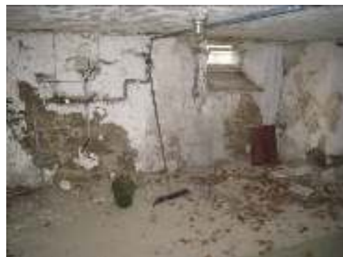
Innenansicht UG Kellerraum 2
