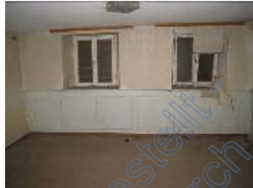
Innenansicht EG Zimmer 1
