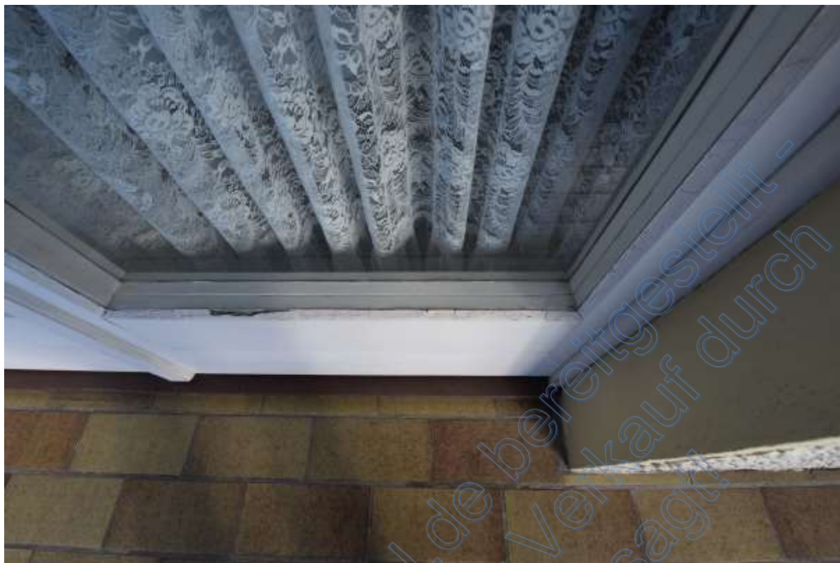
Abb. 68 Erdgeschoss. Wohnung, Balkon, Fensterausstattung
