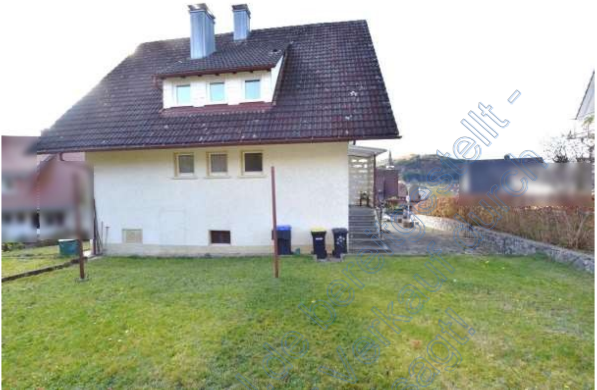
Abb. 34 Bewertungsobjekt, Ansicht von Nord-Osten
