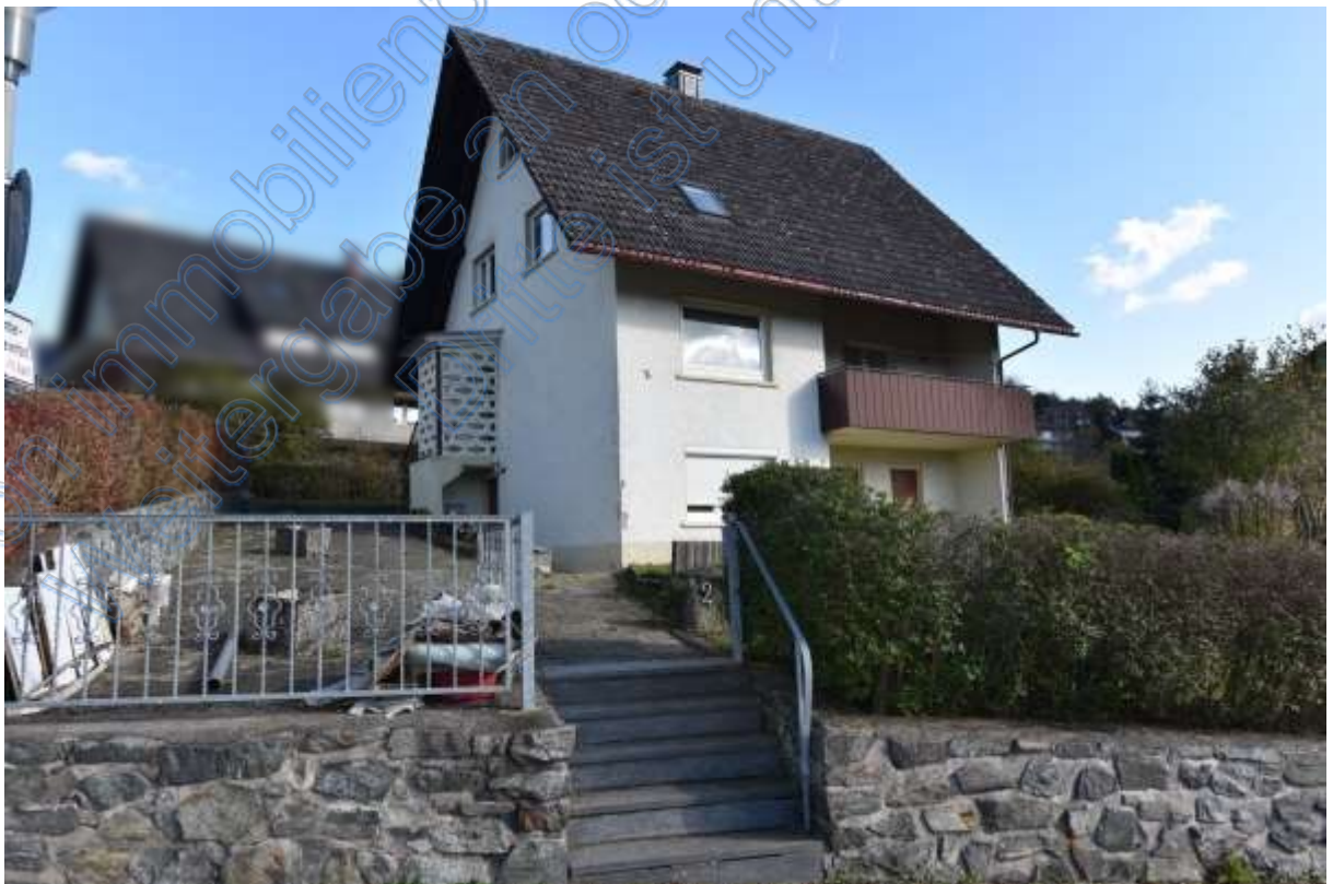
Abb. 31 Bewertungsobjekt, Ansicht von Nord-Westen
