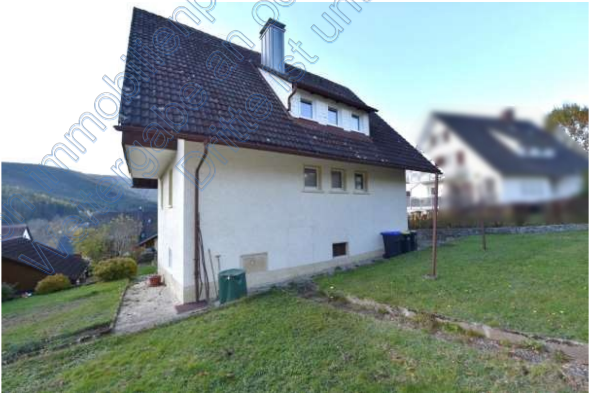
Abb. 35 Bewertungsobjekt, Ansicht von Nord-Osten
