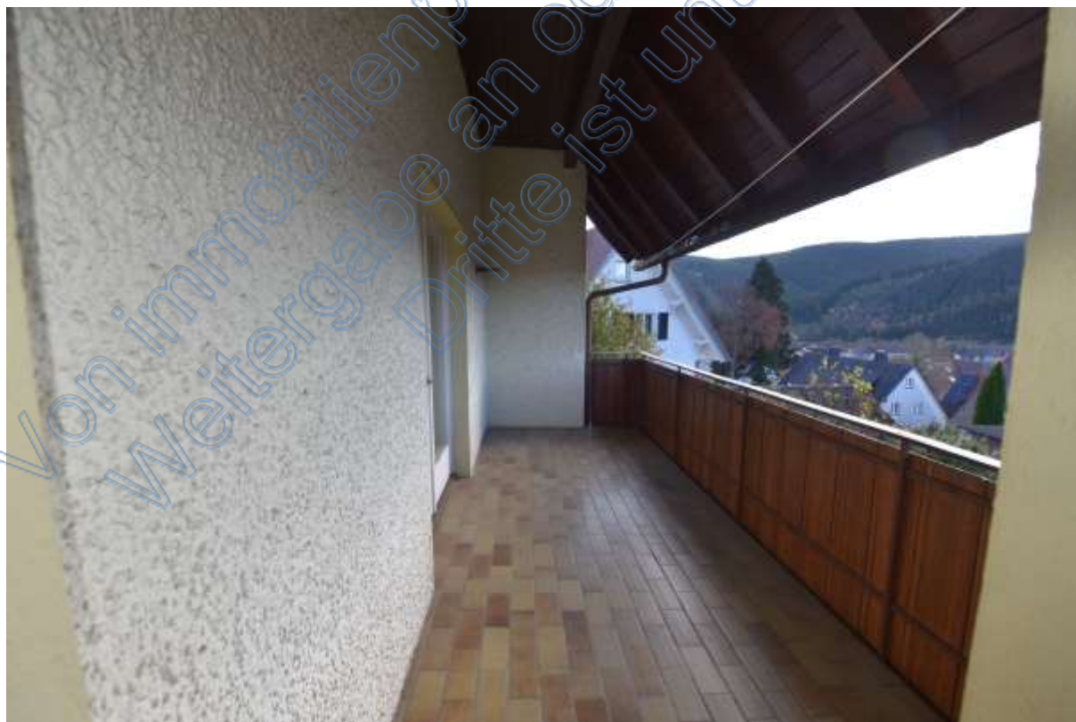
Abb. 65 Erdgeschoss. Wohnung, Balkon
