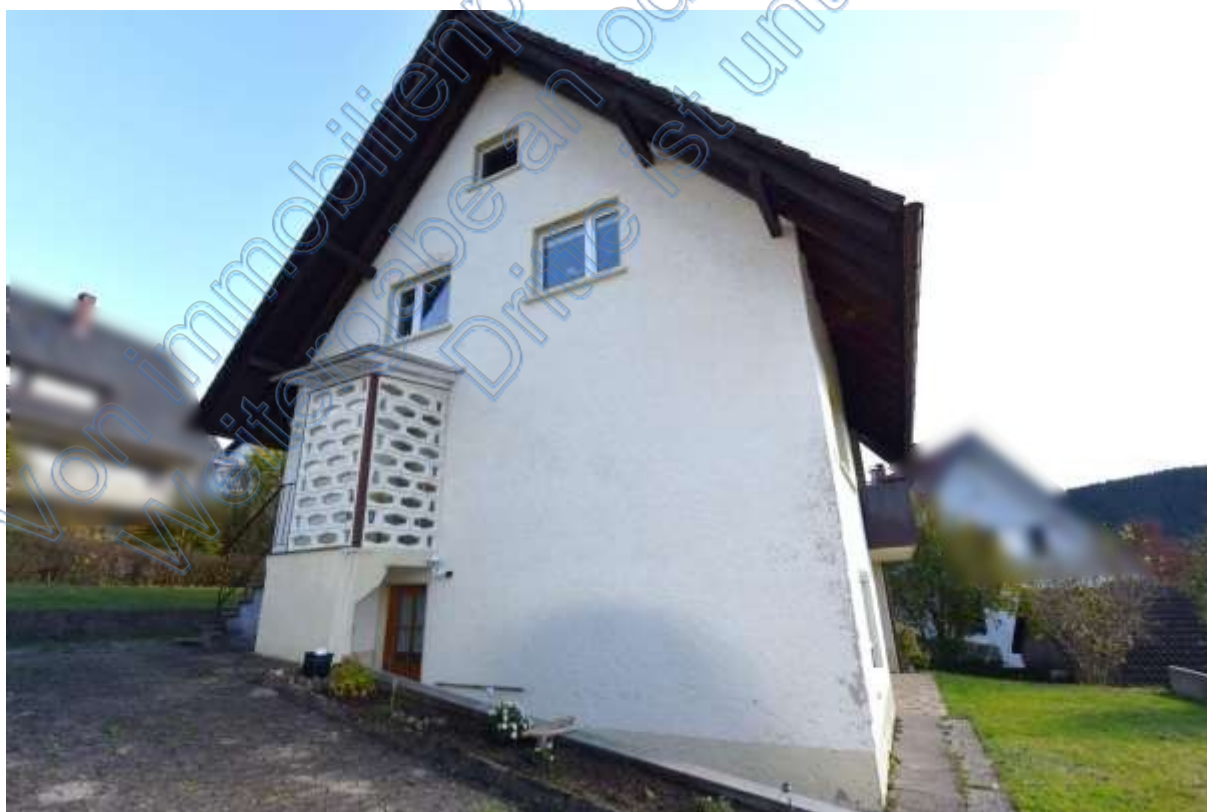
Abb. 33 Bewertungsobjekt, Ansicht von Norden
