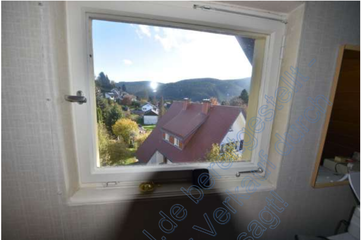
Abb. 94 Dachspitz. Speicher, Fensterausstattung
