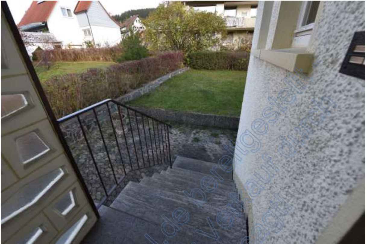
Abb. 62 Erdgeschoss. Hauseingang, Eingangstreppe
