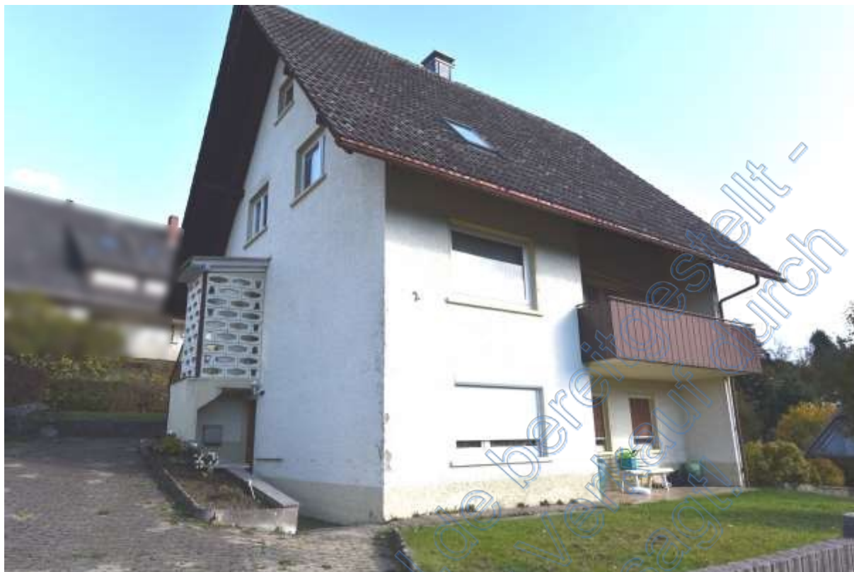
Abb. 32 Bewertungsobjekt, Ansicht von Nord-Westen
