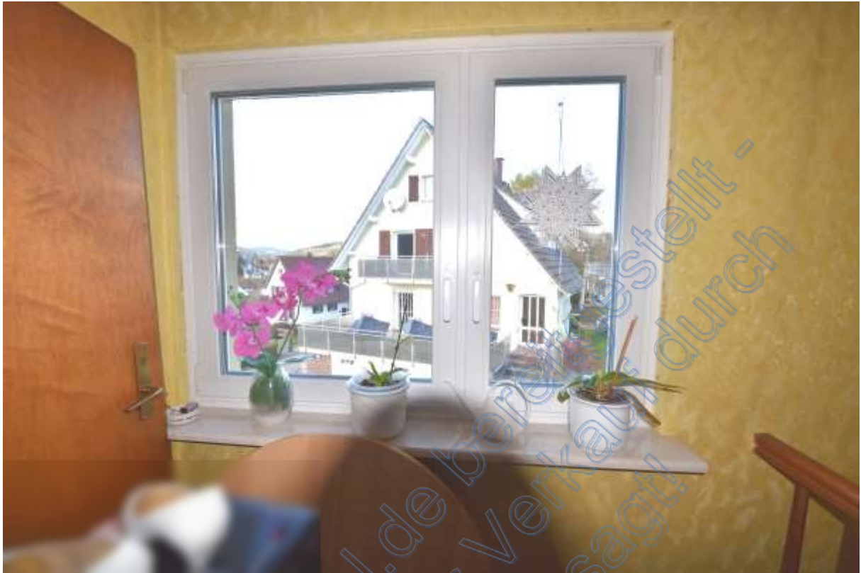
Abb. 78 Dachgeschoss. Hausflur, Fensterausstattung
