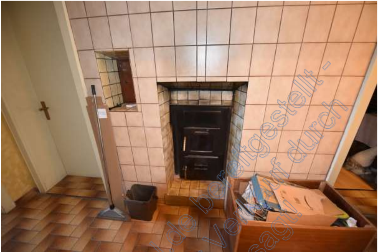
Abb. 54 Kellergeschoss. Flur, Feuerungsstelle Kachelofen
