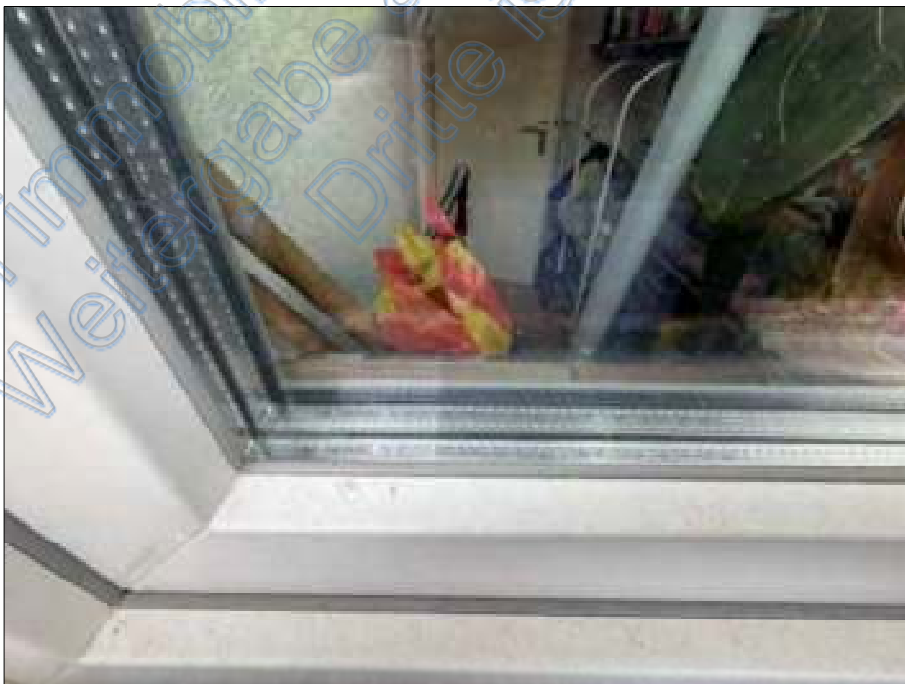
Bild 34: Hanggeschoss, Detail – Kunststoffisoliervergasung
