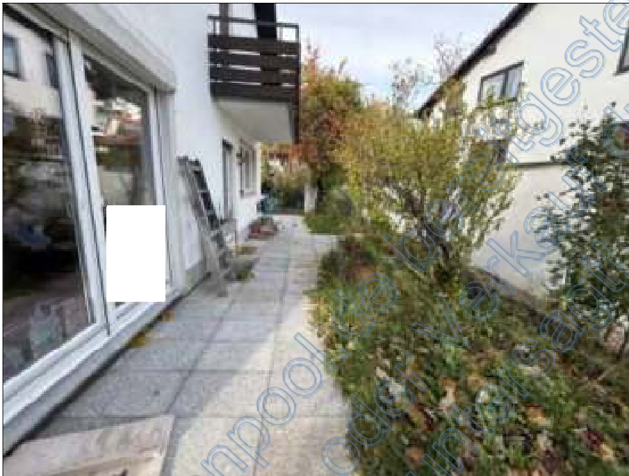
Bild 13: Erdgeschoss, östlicher Terrassenbereich giebelseitig
