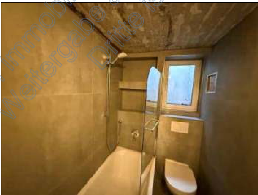
Bild 32: Appartement Nr. 2, Hanggeschoss, Badezimmer
