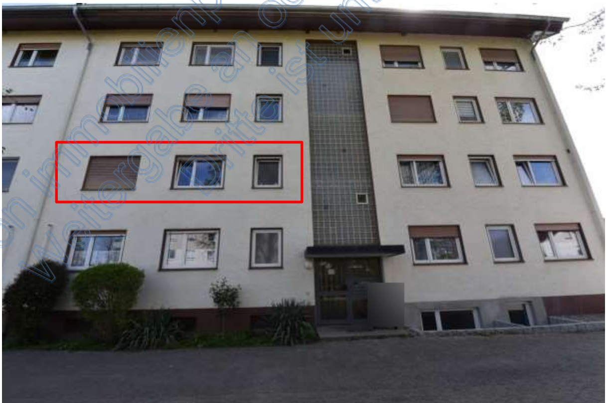
Abb. 27 Gebäudeansicht, Lage der Wohnung Nr. 4 im 1. OG links
