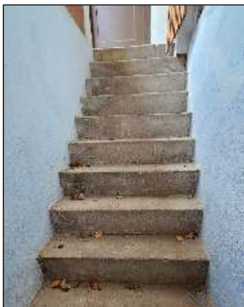
Außentreppe zum Keller-/ Hanggeschoss
