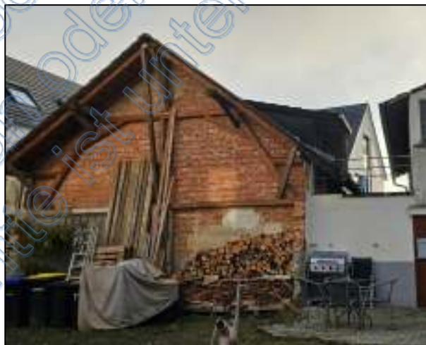
Schopf Nordansicht (über das Nachbargrundstück)
