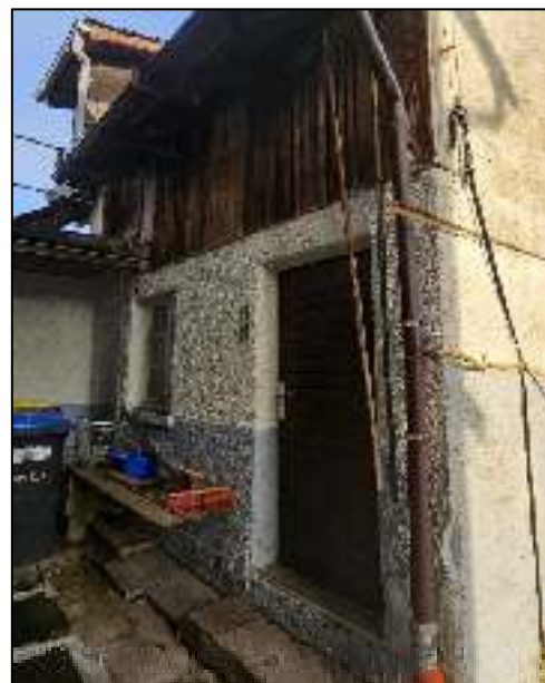
Ansicht Scheune Südwestseite
