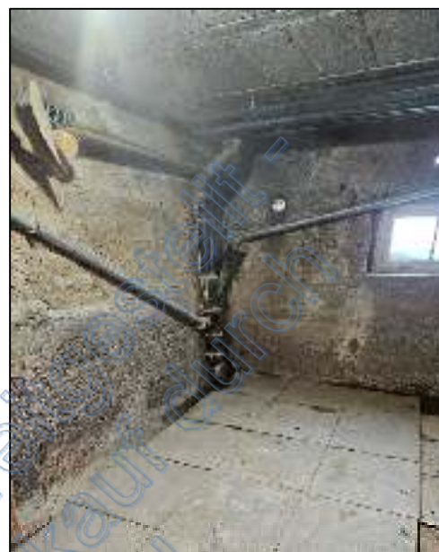
Hanggeschoss – Boden mit Platten ausgelegt
