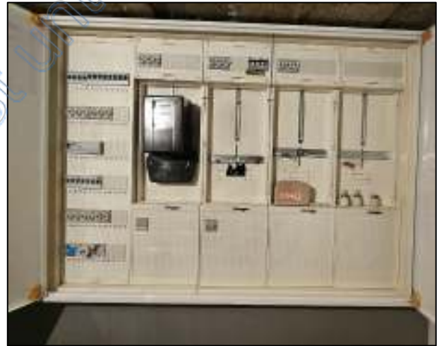
Verteilerkasten/Zählerplatz
