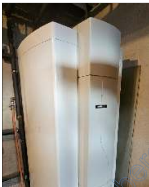
Warmwasserspeicher
