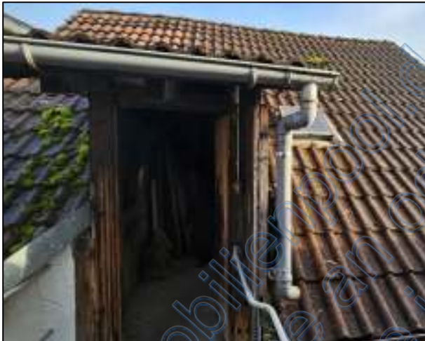
Eingangsbereich Dachgeschoss Scheune – Erreichbar über eine Verbindung zwischen dem OG des Hauses und DG Scheune
