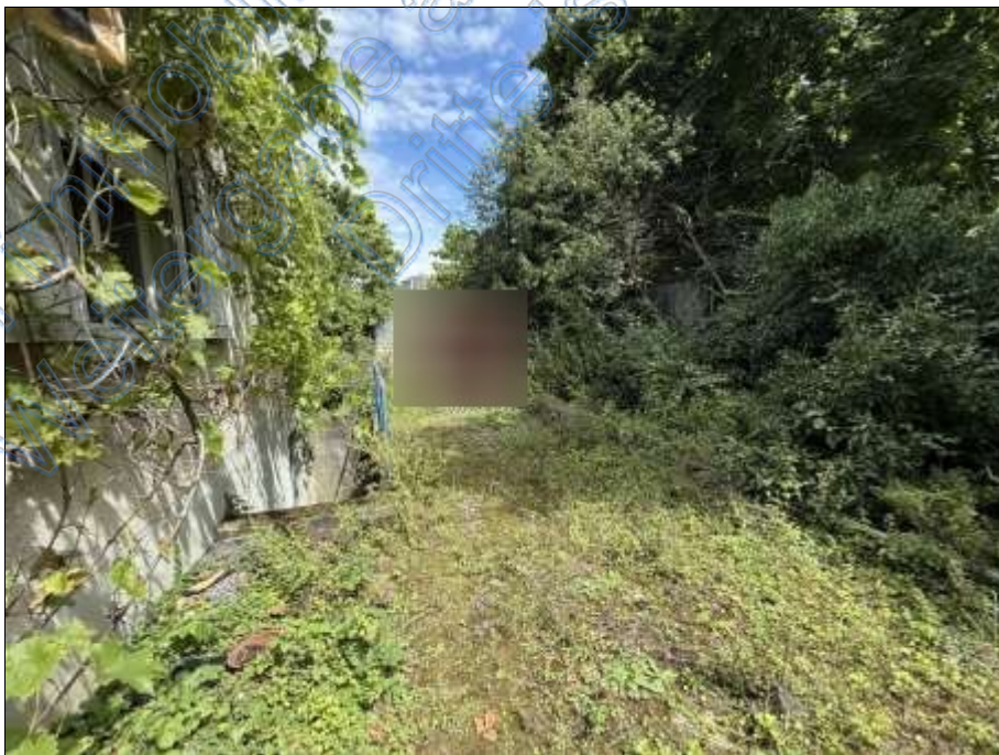
Bild 6: Pkw-Stellplatz im Bereich der Einfahrt, Kelleraußentreppe
