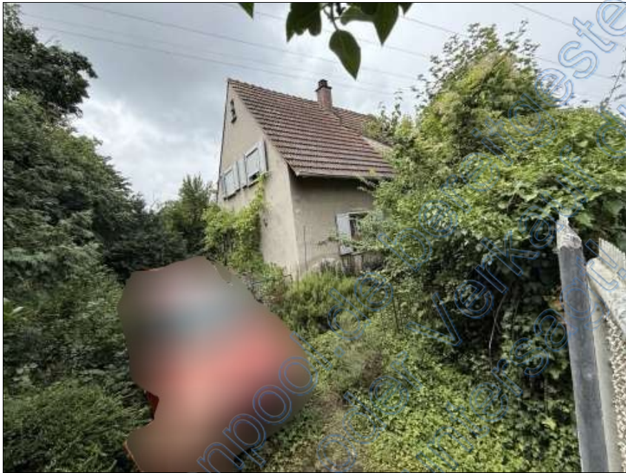
Bild 5: Blick von der Einfahrt zum Wohnhaus
