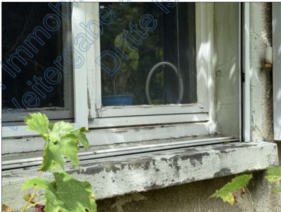
Bild 10: Detail – Holzfenster im Altzustand
