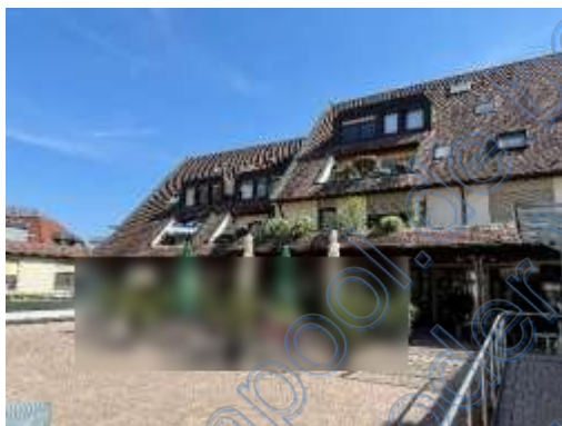
Innenhof, Ansicht von Westen
