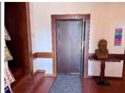
Aufzug zur Wohnung
