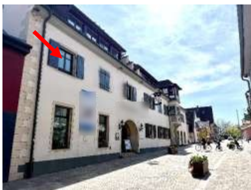
Basler Straße – Ansicht von Norden
