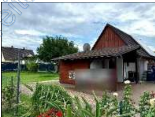
Nebengebäude – Schuppen, Abstellraum
