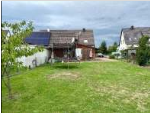
Ansicht Nebengebäude von Osten
