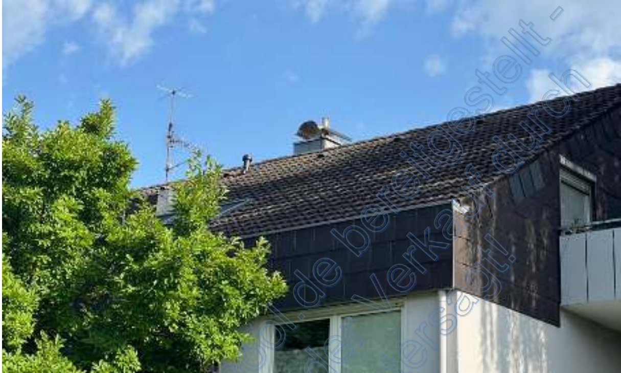
Abbildung 11: Dachansicht mit Blick auf Tonziegel und Wandverkleidung
