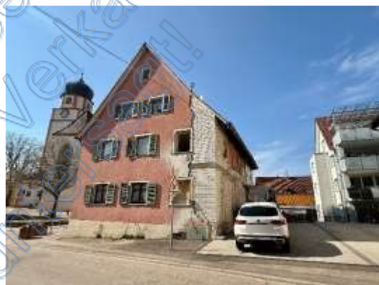
Ansicht von Süd-Osten
