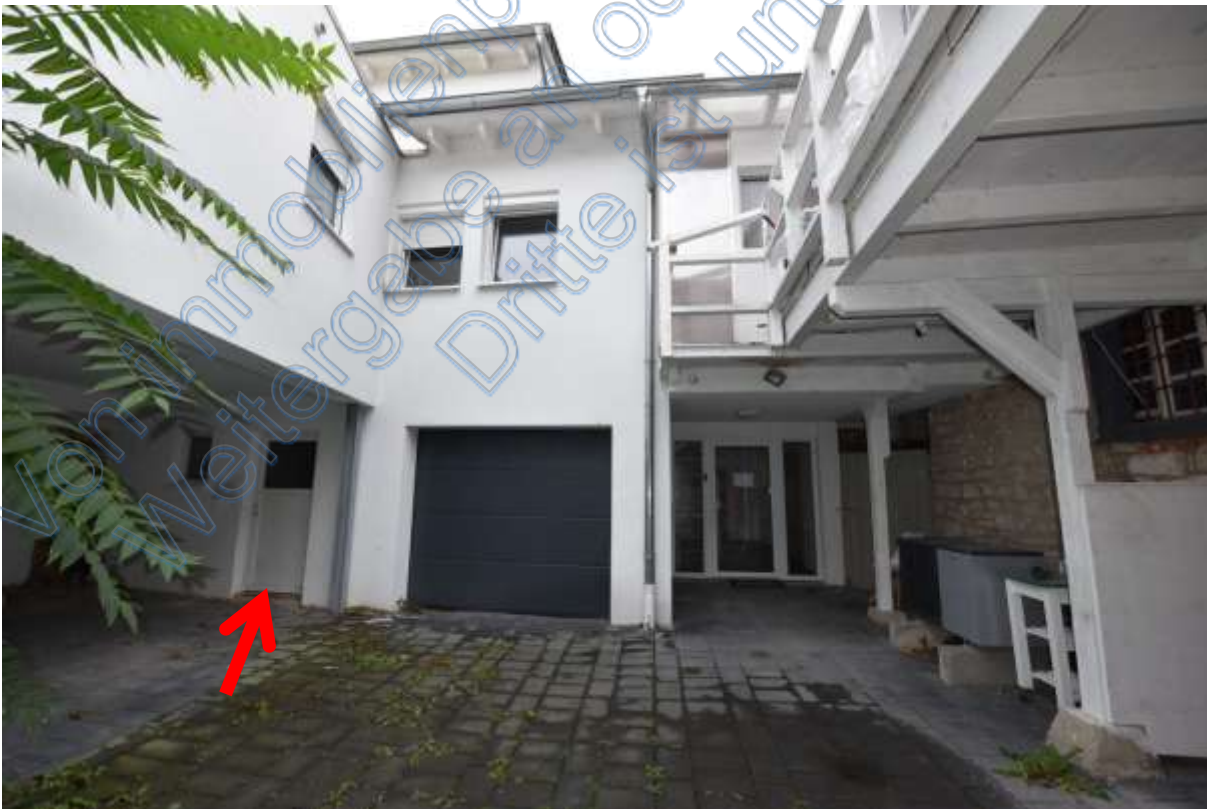
Abb. 103 Haus Nr. 1a. Hofansicht. Eingang Heizungsraum (Pfeil), Garage
