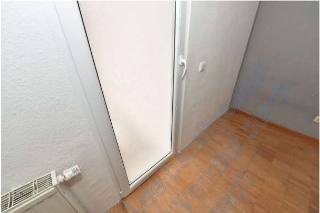
Abb. 180 Haus Nr. 3. Obergeschoss. Wohnung 2. Zimmer. Neuere Fenstertür
