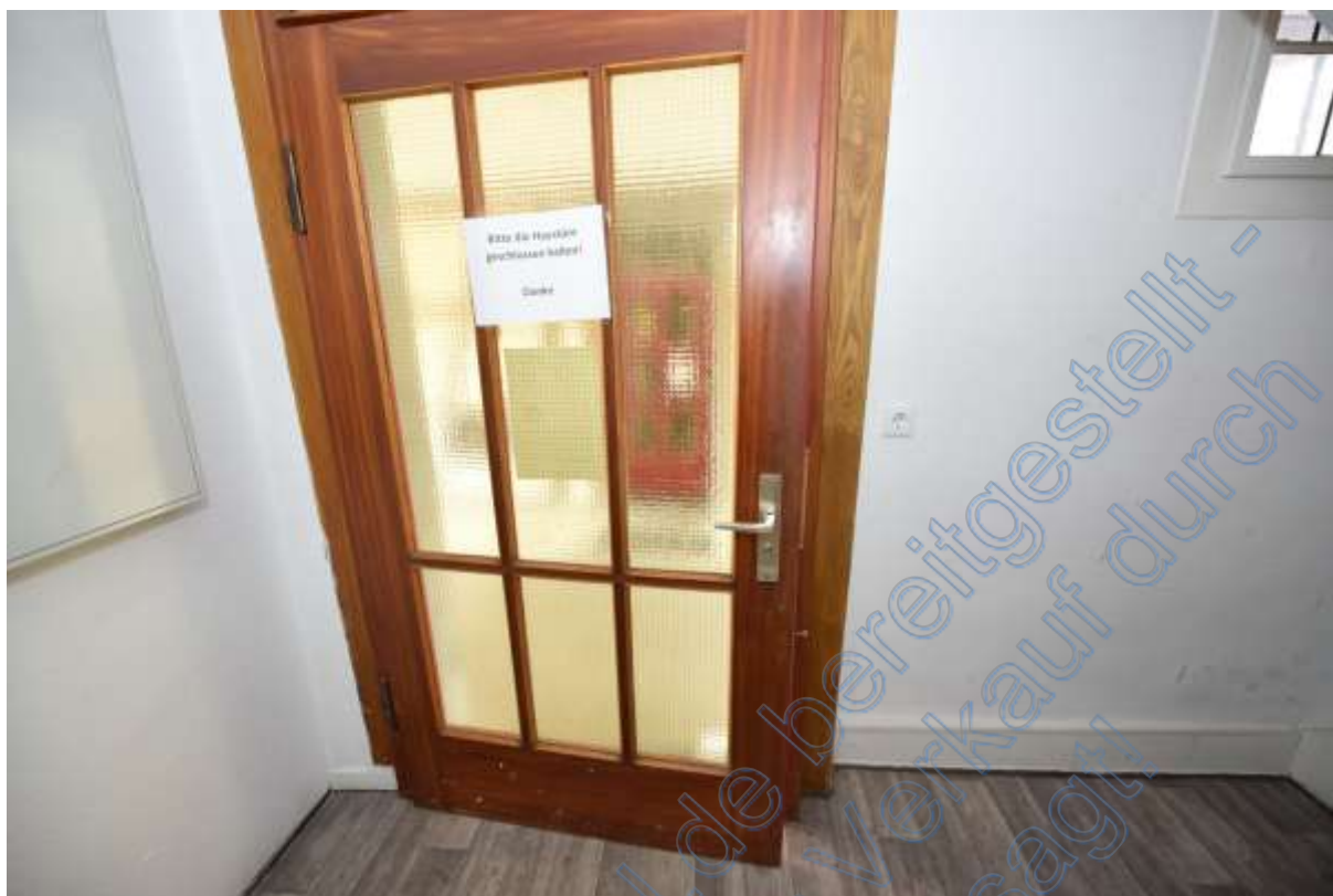
Abb. 150 Haus Nr. 3. Erdgeschoss. Hauseingang, Haustür
