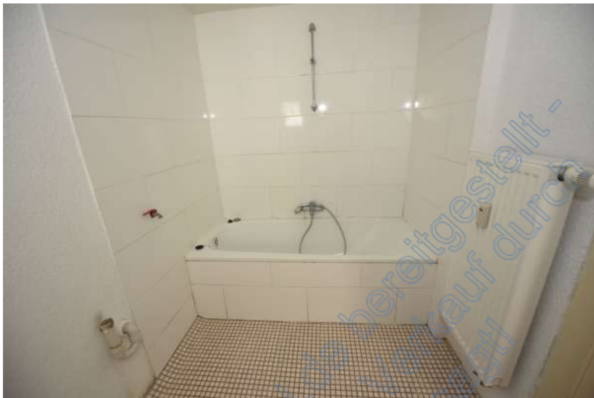
Abb. 162 Haus Nr. 3. Erdgeschoss. Wohnung 1. Bad
