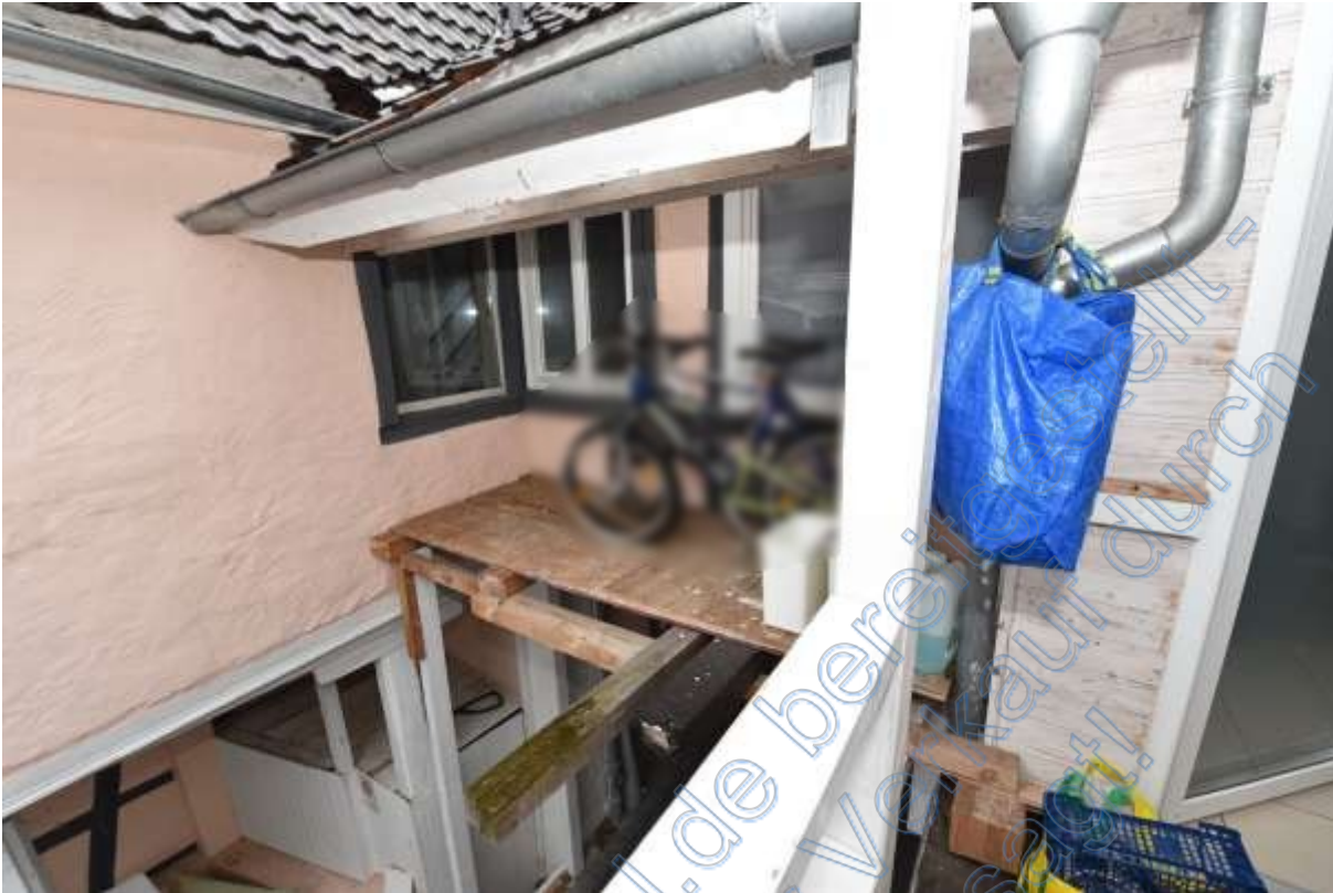
Abb. 86 Haus Nr. 1. Obergeschoss. Wohnung 2. Balkon im Hof
