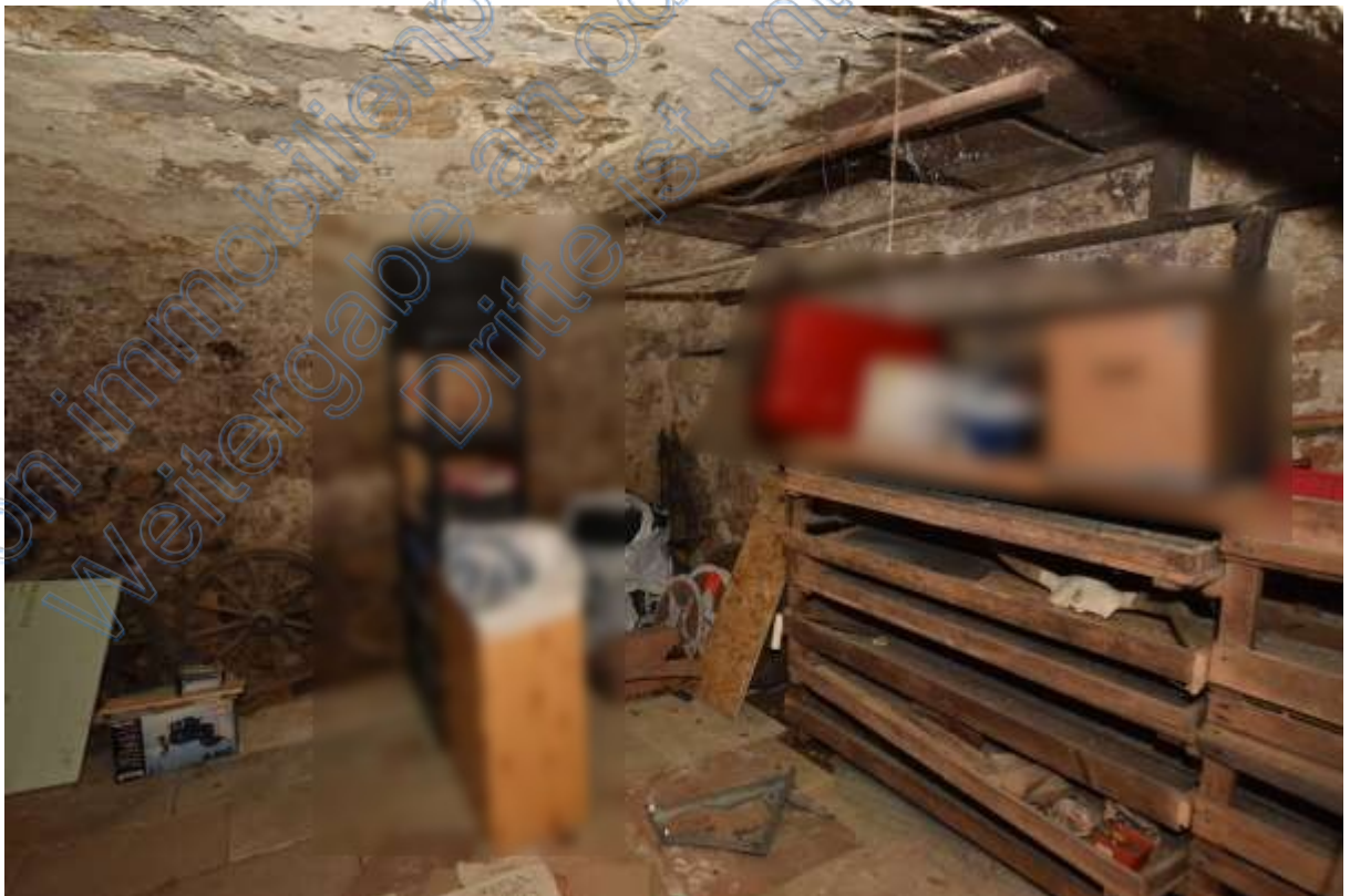
Abb. 61 Haus Nr. 1. Kellerraum
