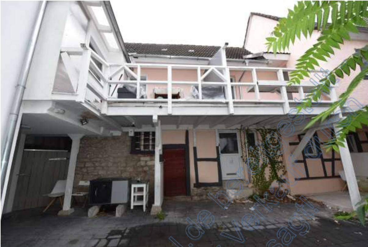
Abb. 46 Haus Nr. 3. Hofansicht
