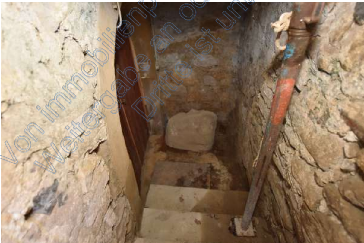
Abb. 59 Haus Nr. 1. Zugang zum Keller, Kellertreppe
