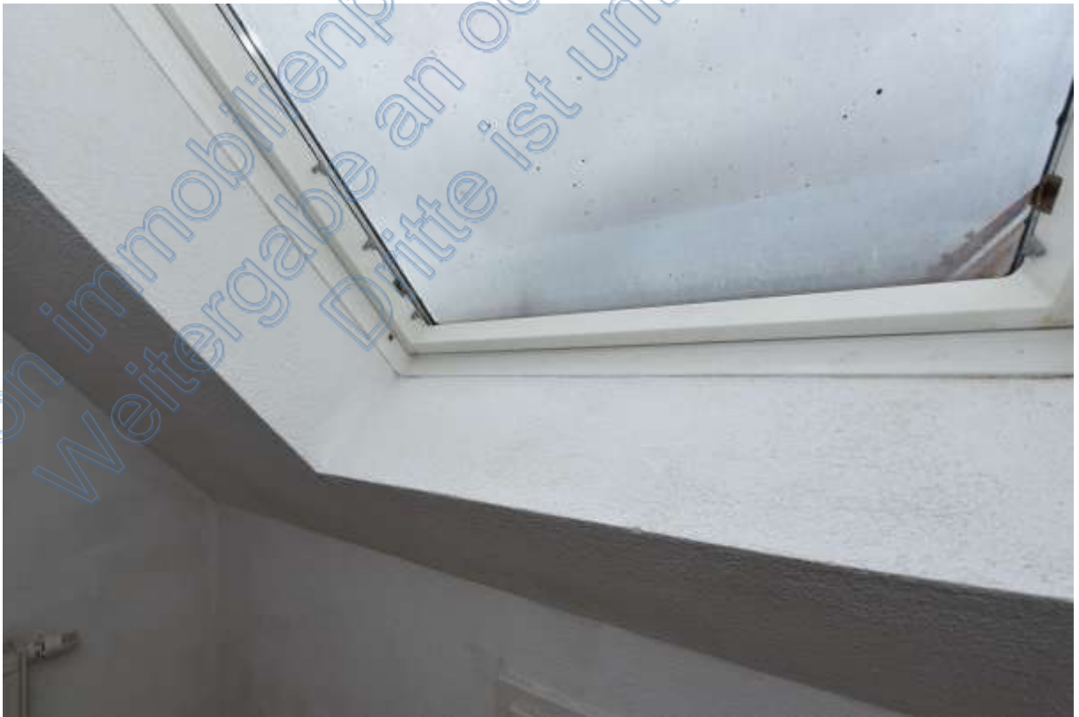
Abb. 185 Haus Nr. 3. Dachgeschoss. Wohnung 2. Dachlegefenster
