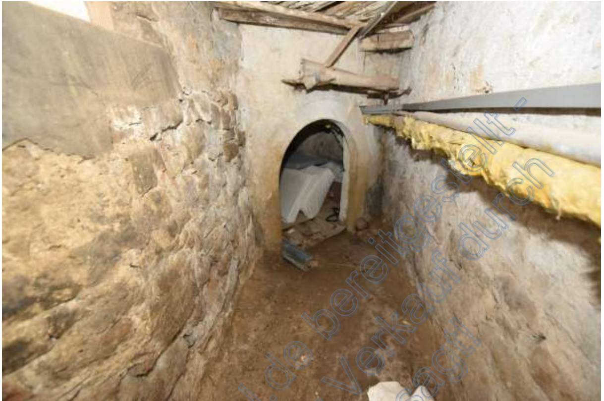
Abb. 48 Haus Nr. 3. Kellergang
