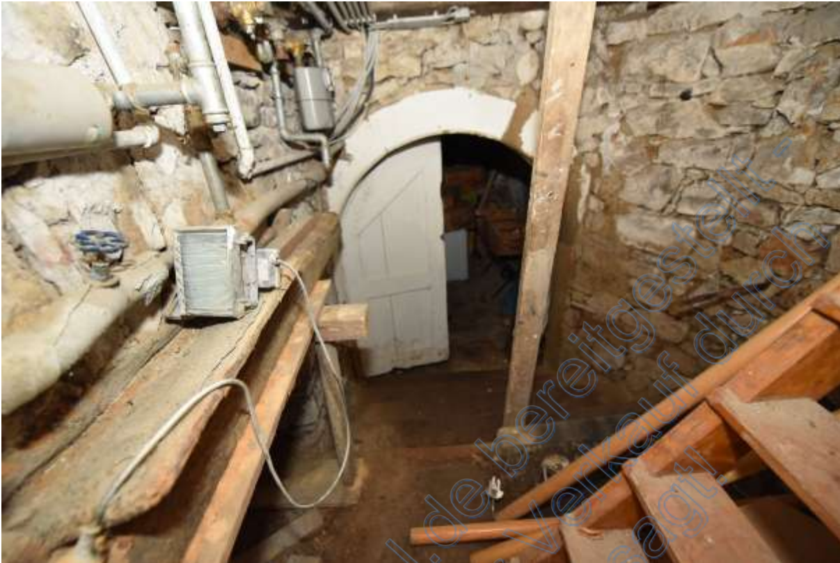
Abb. 50 Haus Nr. 3. Kellergang
