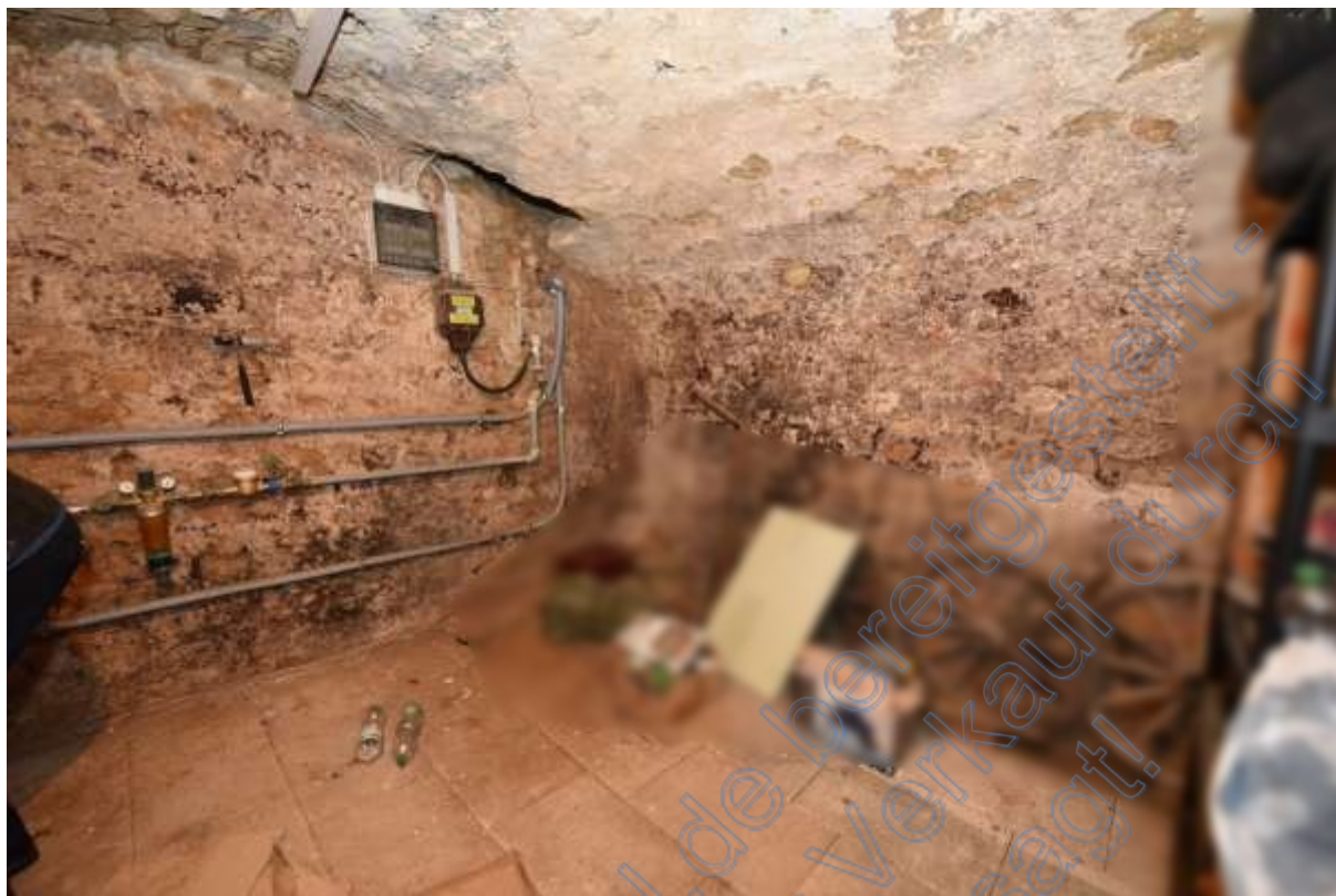
Abb. 62 Haus Nr. 1. Kellerraum
