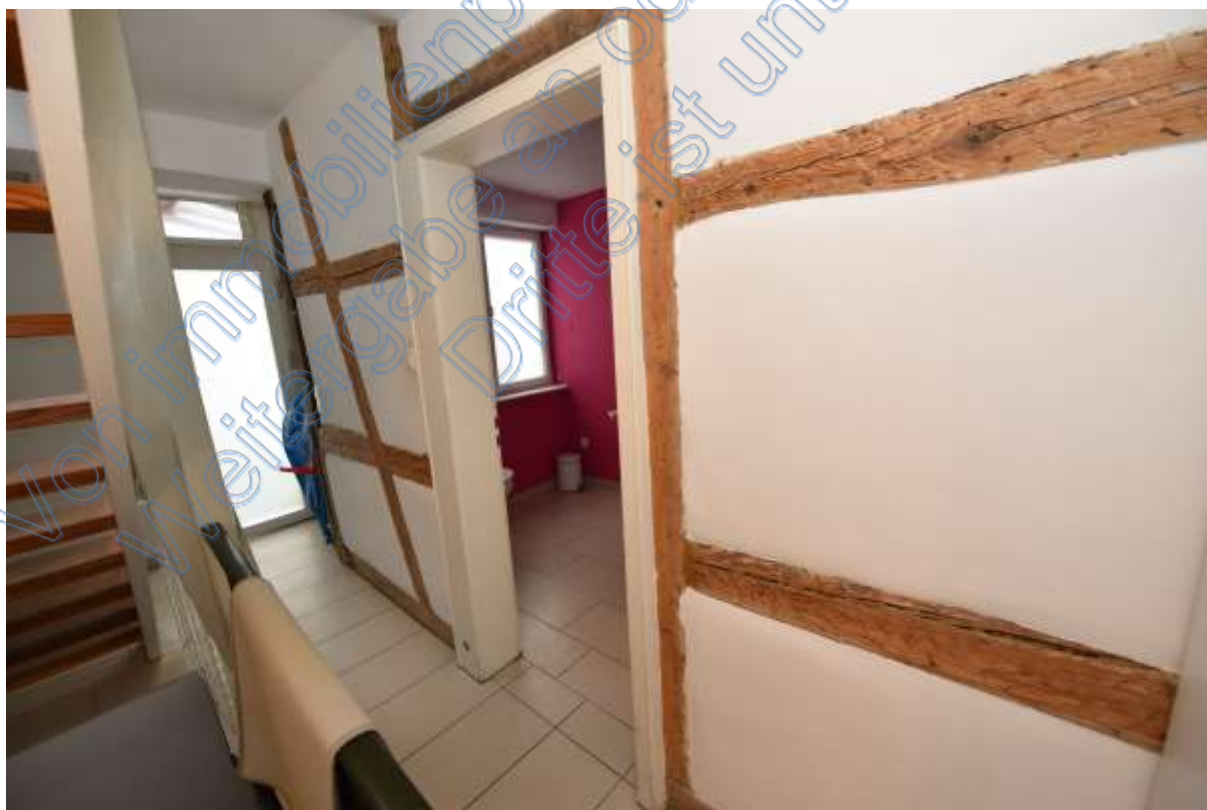
Abb. 75 Haus Nr. 1. Obergeschoss. Wohnung 2. Flur
