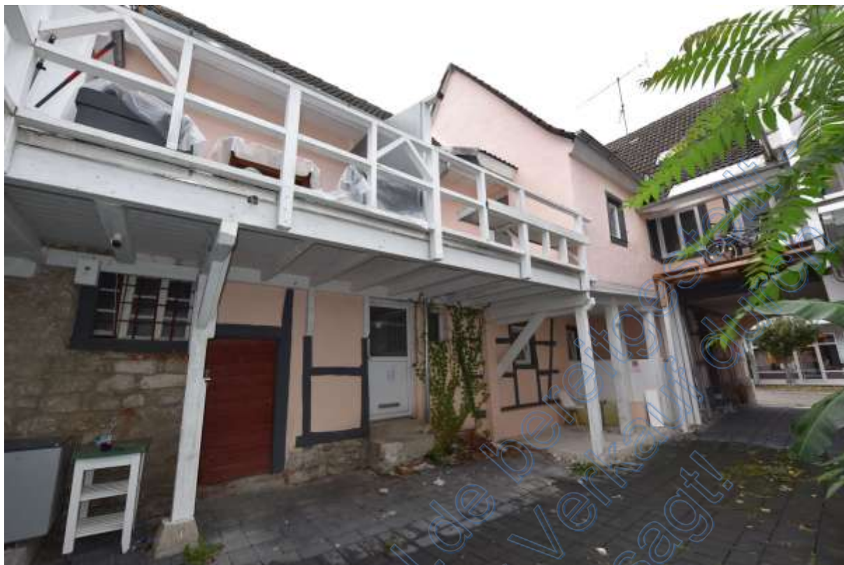
Abb. 54 Haus Nr. 3. Hofansicht
