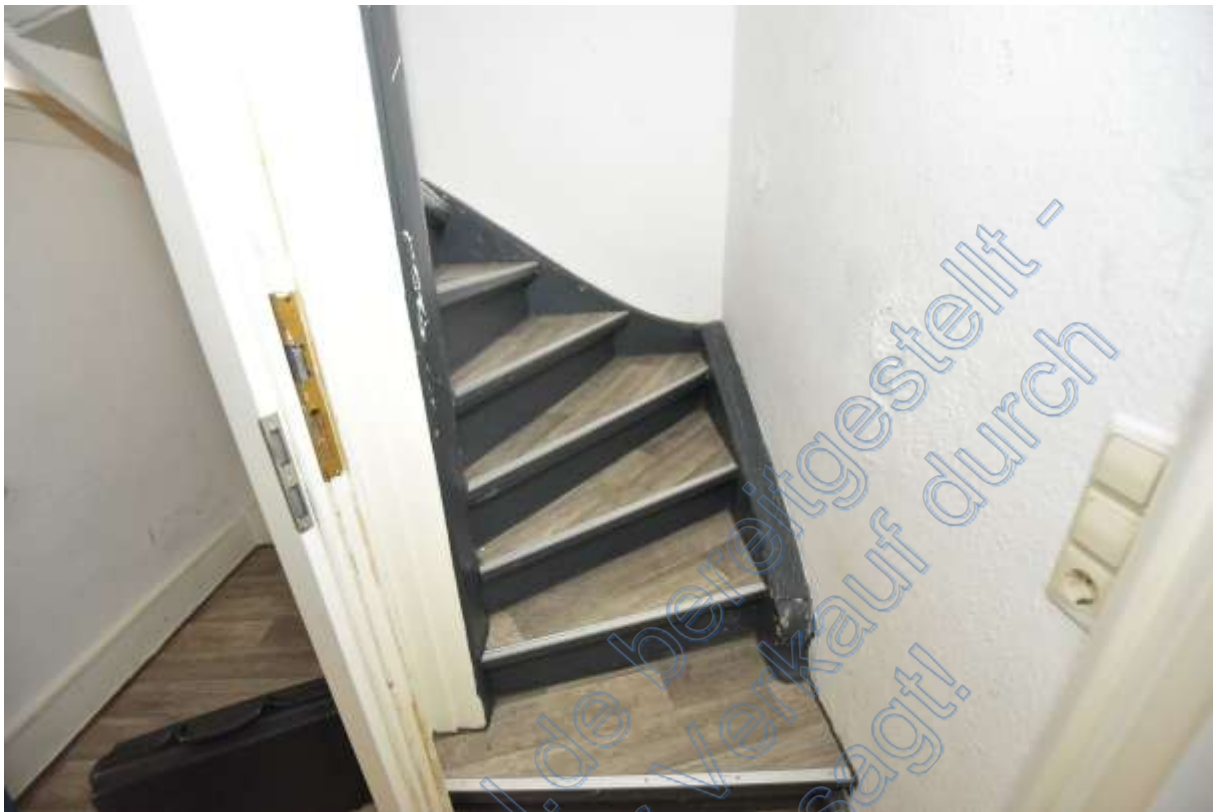
Abb. 164 Haus Nr. 3. Erdgeschoss. Hausflur. Ausgang Wohnung 2 Obergeschoss
