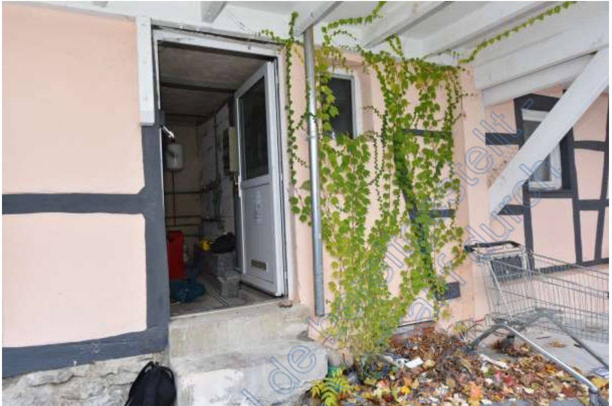
Abb. 196 Haus Nr. 3. Erdgeschoss. Hof. Eingang zum Heizungsraum
