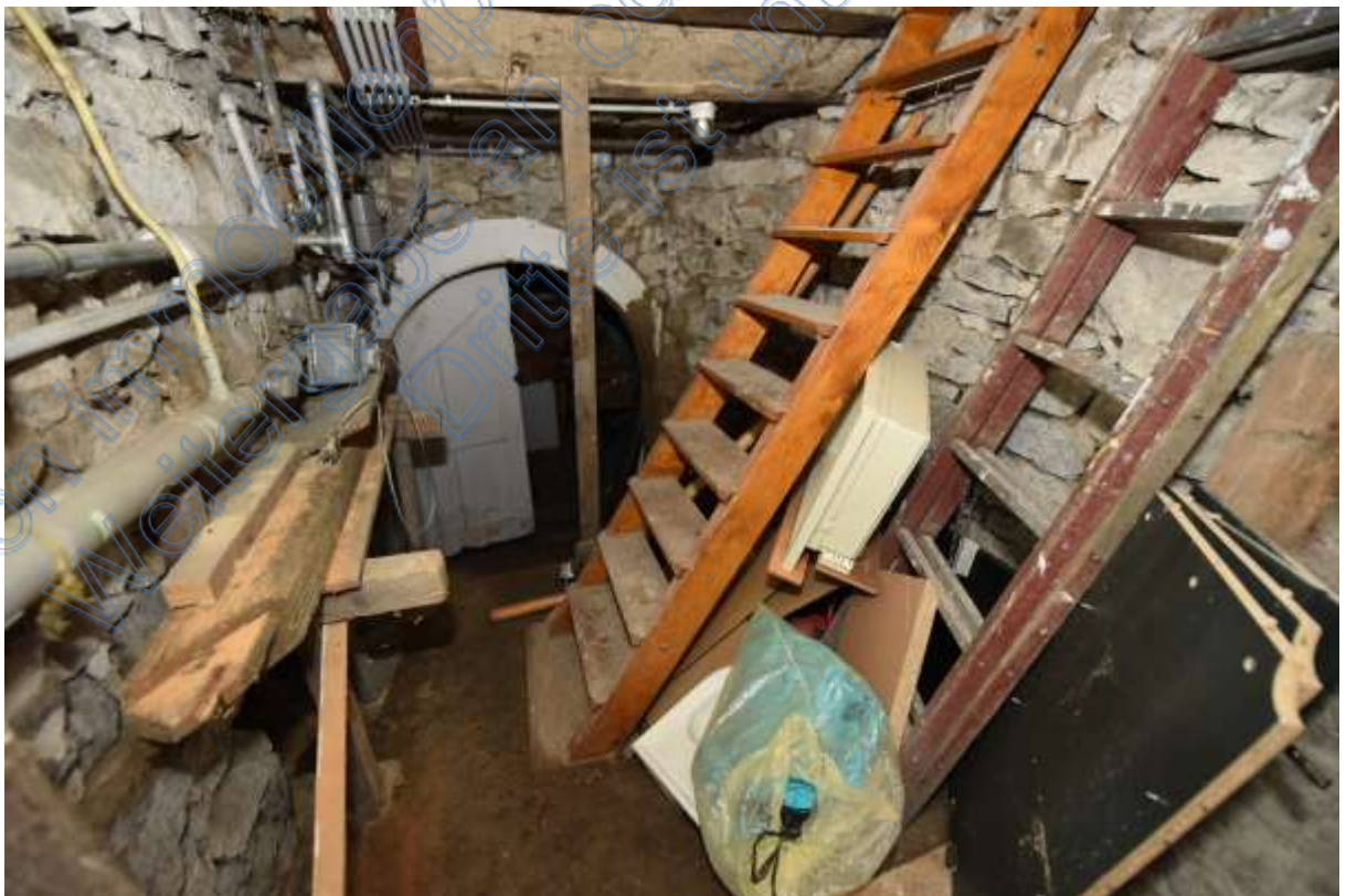
Abb. 49 Haus Nr. 3. Kellergang
