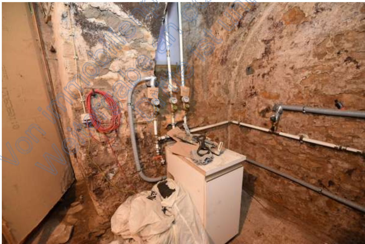
Abb. 63 Haus Nr. 1. Kellerraum
