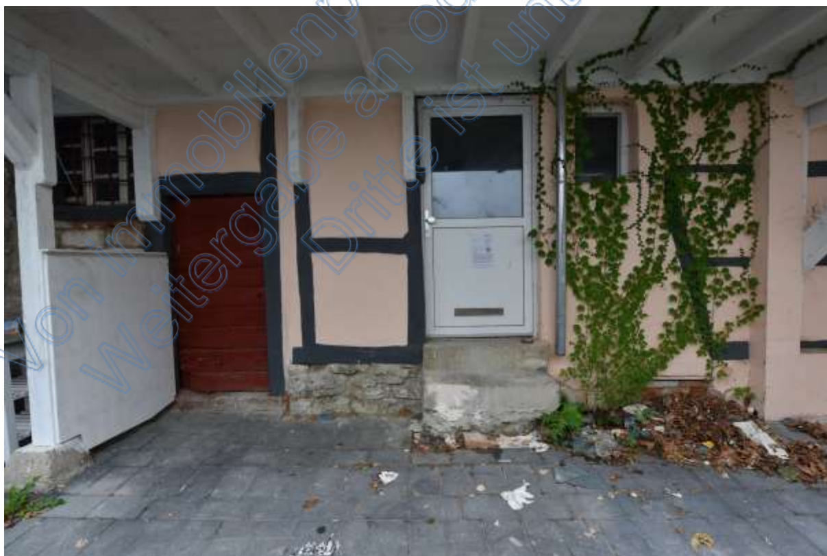
Abb. 55 Haus Nr. 3. Hofansicht
