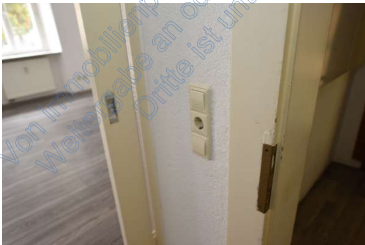
Abb. 163 Haus Nr. 3. Erdgeschoss. Wohnung 1. Elektrik erneuert
