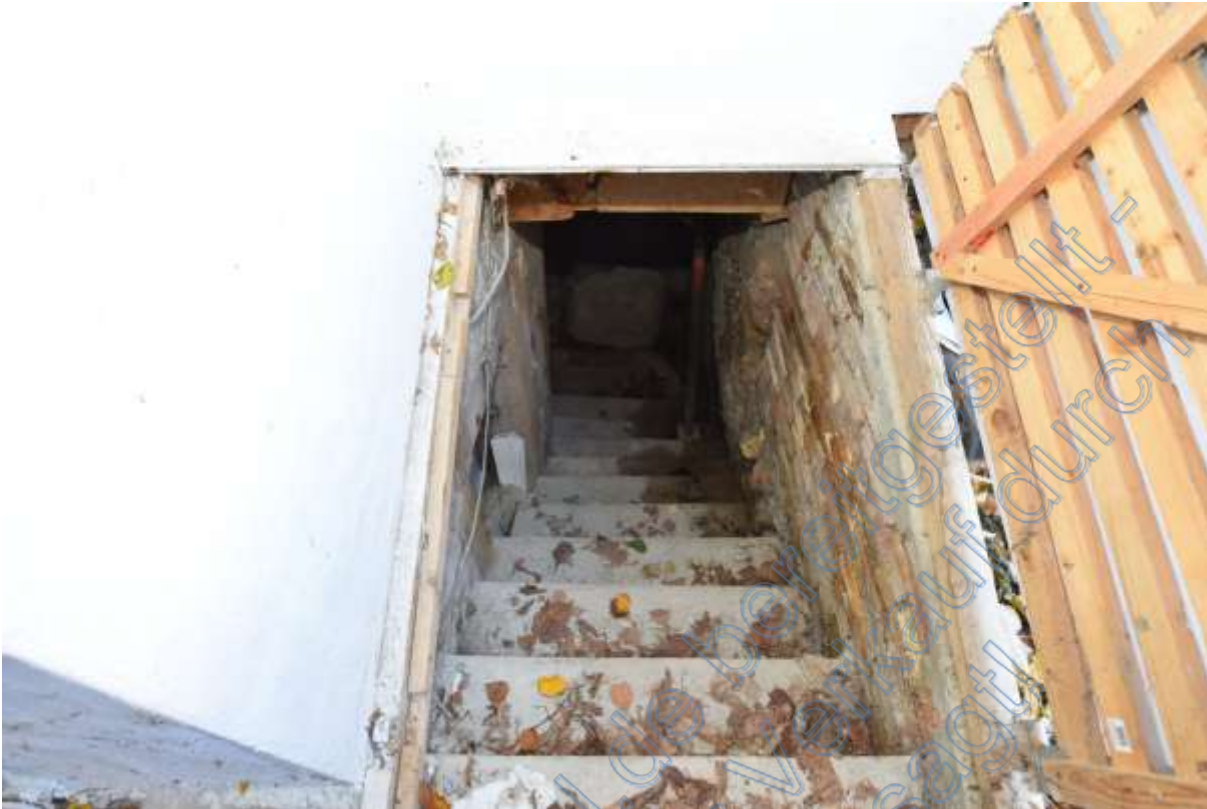
Abb. 58 Haus Nr. 1. Zugang zum Keller von außen, Kellertreppe
