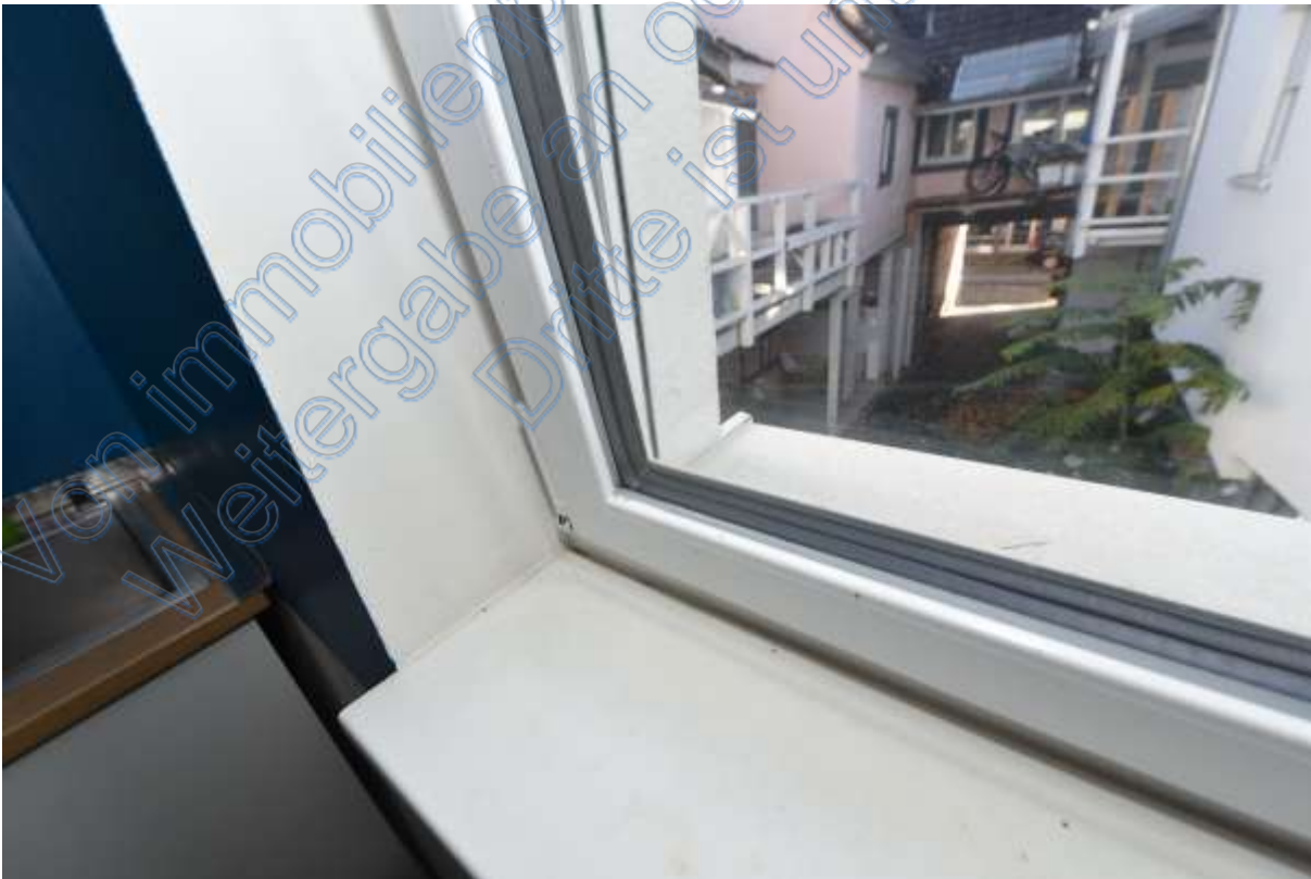
Abb. 131 Haus Nr. 1a. Obergeschoss links, Wohnung Nr. 1. Fensterausstattung
