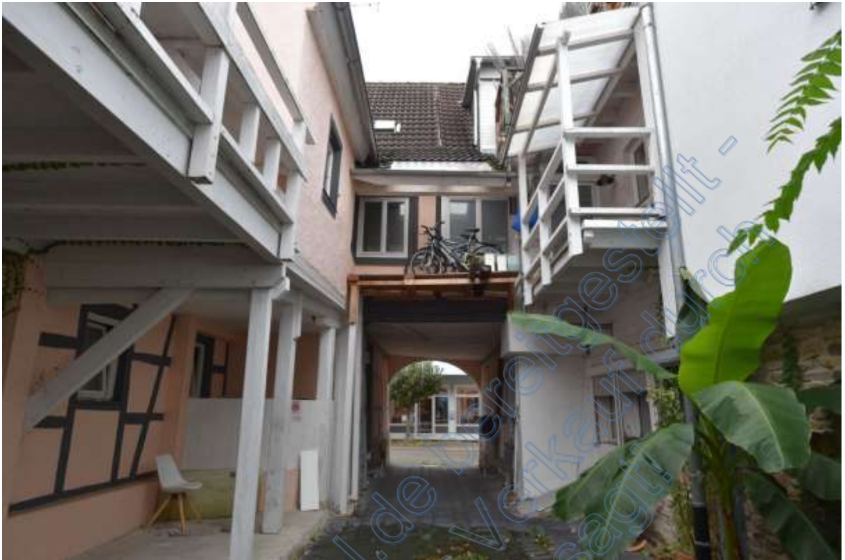
Abb. 56 Haus Nr. 1 und Nr. 3. Durchfahrt und Hofansicht
