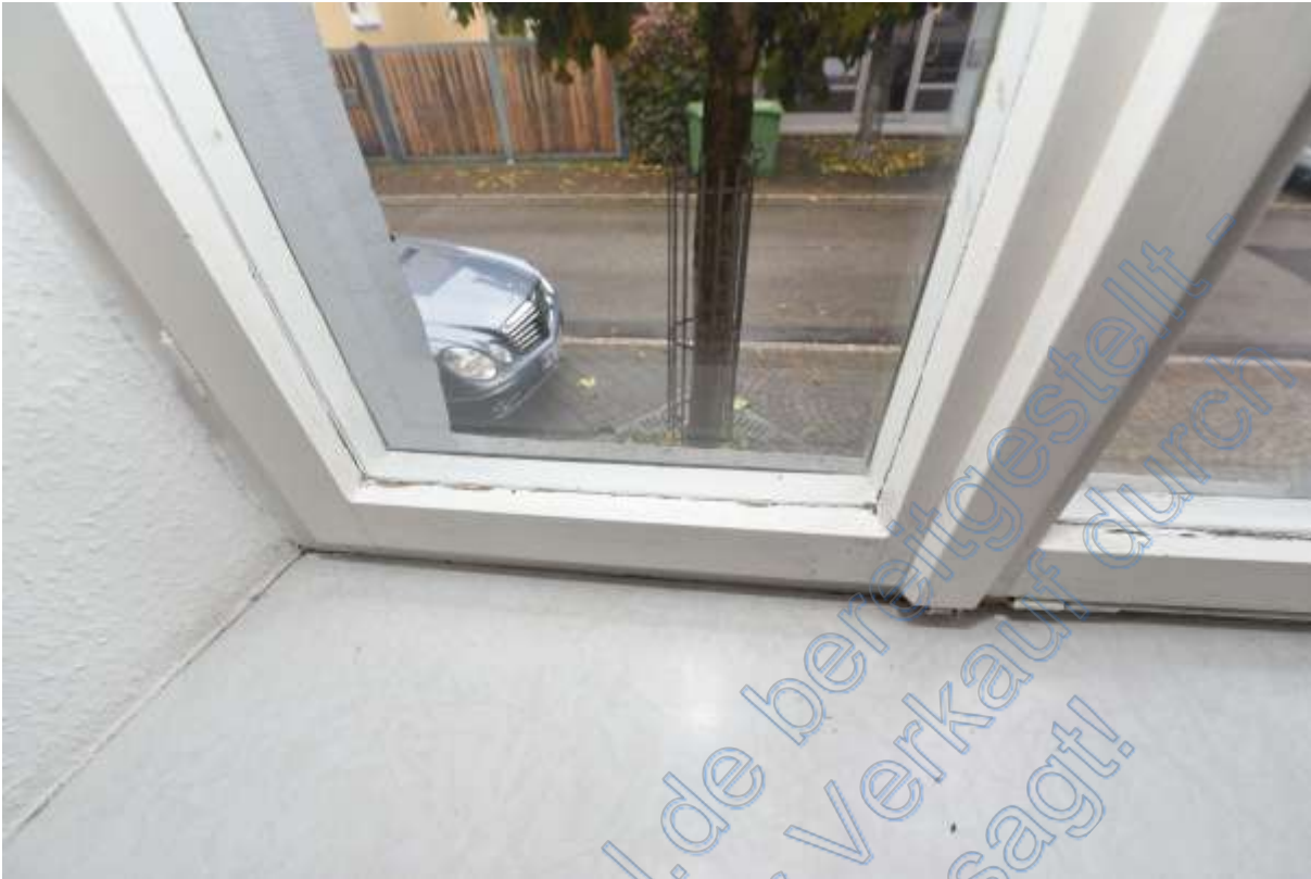
Abb. 154 Haus Nr. 3. Erdgeschoss. Wohnung 1. Wohnzimmer. Fensterausstattung
