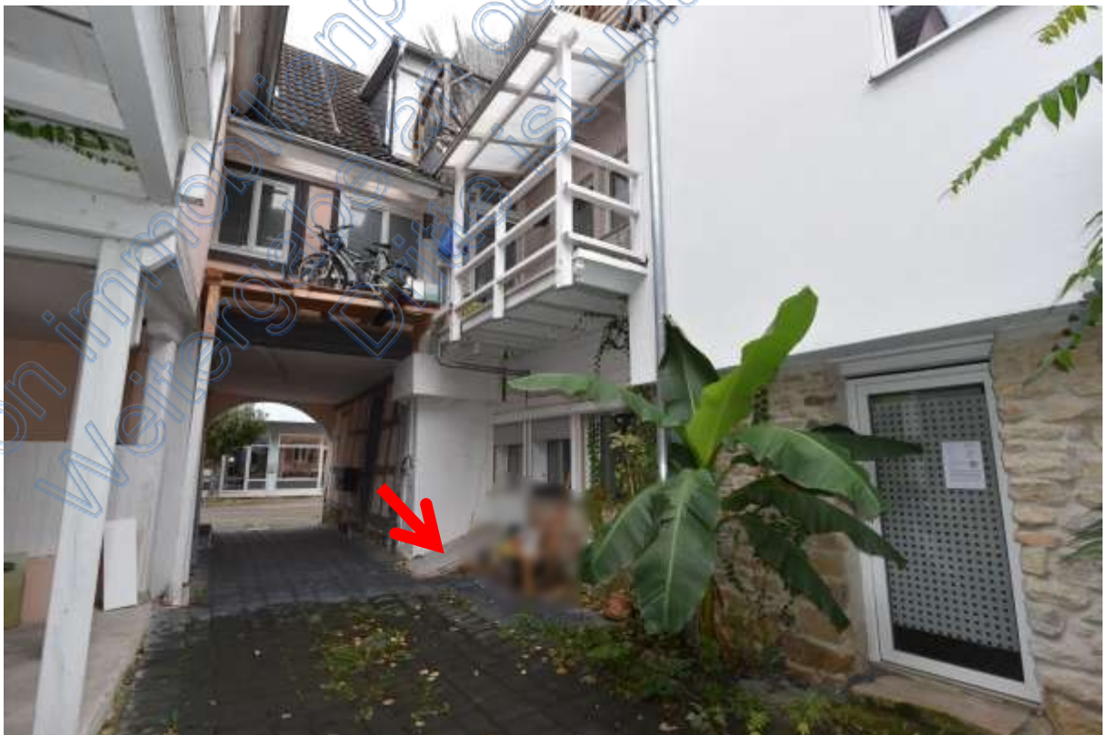
Abb. 57 Haus Nr. 1. Durchfahrt. Hofansicht, Zugang zum Keller (Pfeil)
