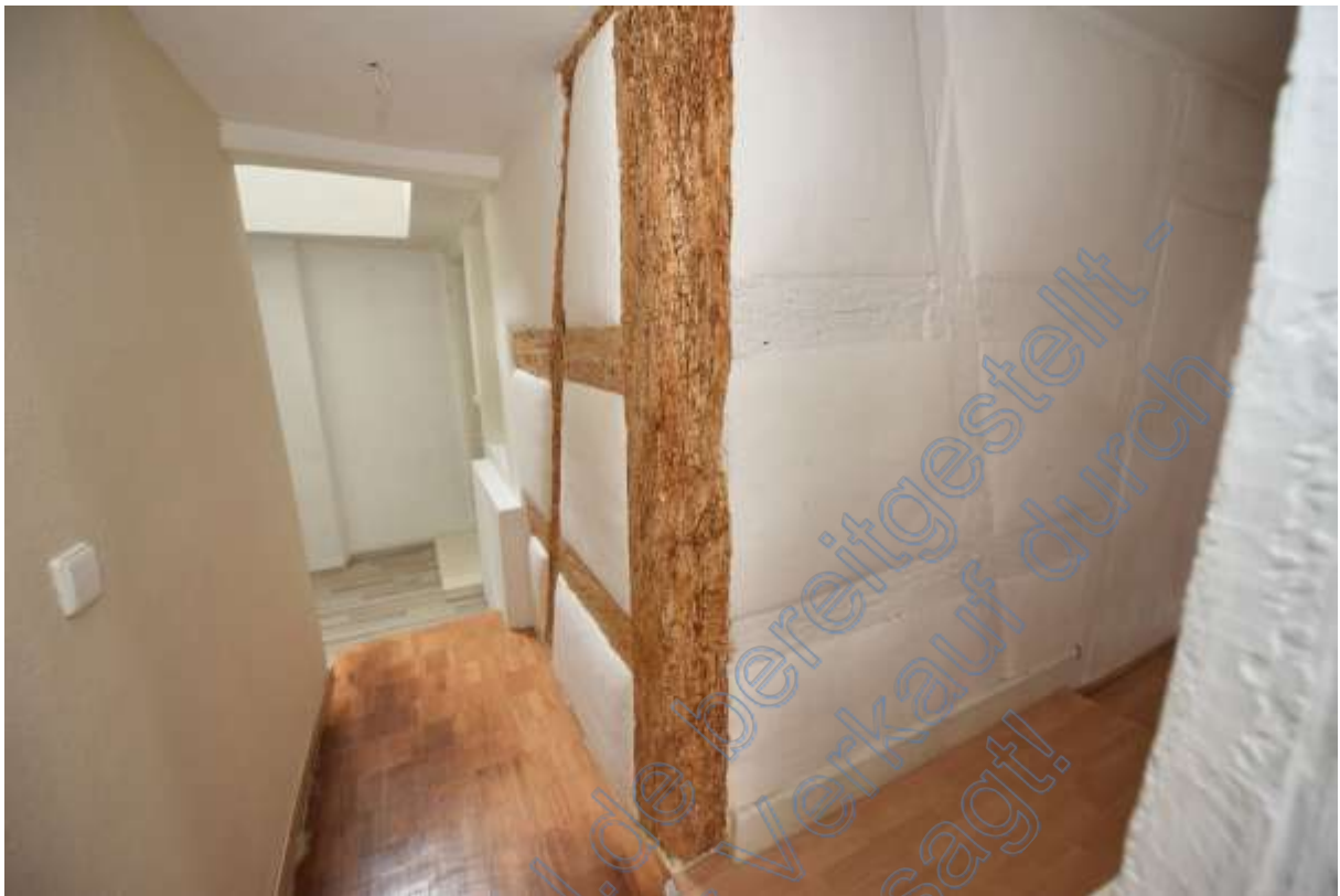
Abb. 192 Haus Nr. 3. Dachgeschoss. Wohnung 2. Flur
