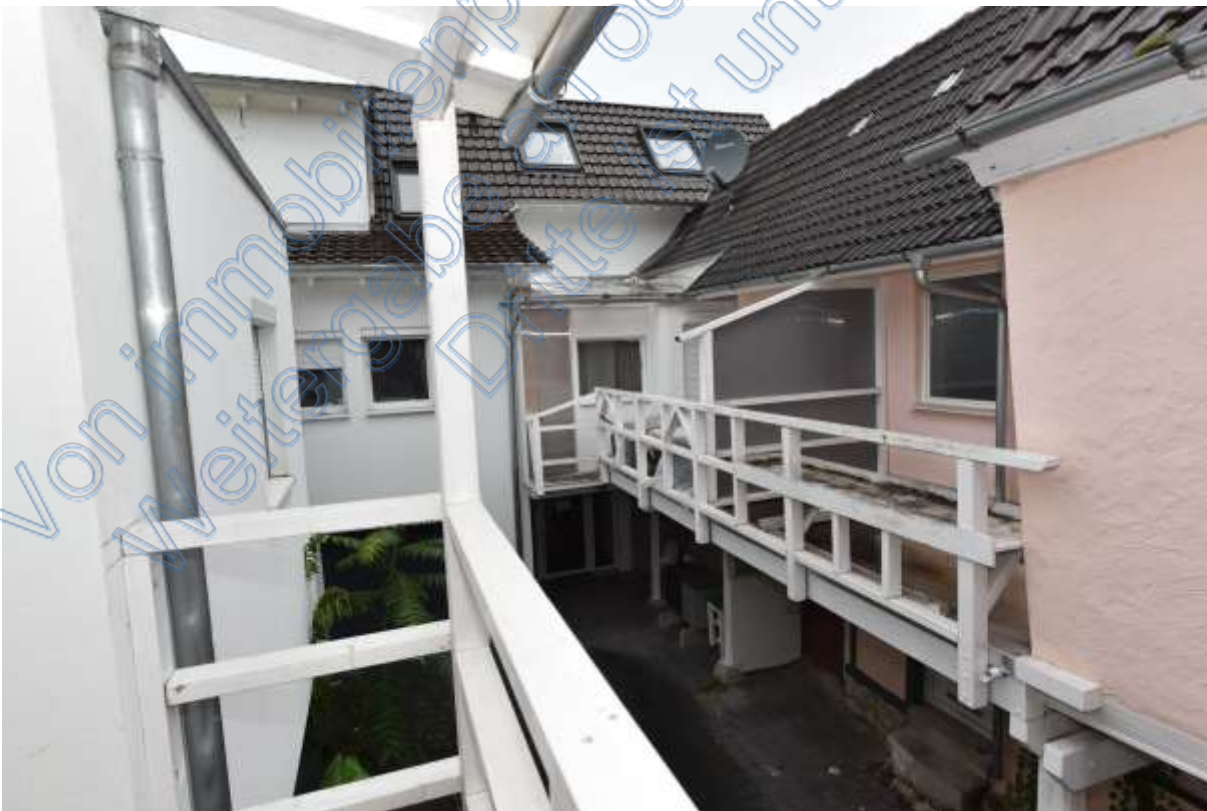
Abb. 87 Haus Nr. 1. Obergeschoss. Wohnung 2. Balkon. Blick auf Haus 1a und 3
