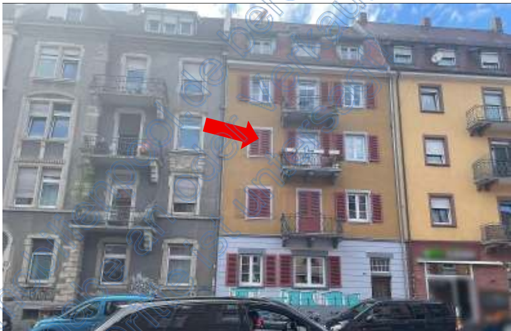
Ansicht von der Escholzstraße aus
