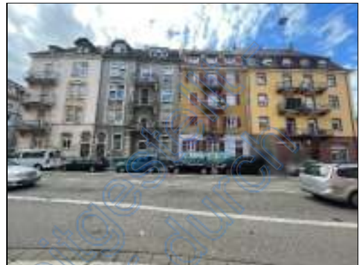
Ansicht von Süd-Osten
