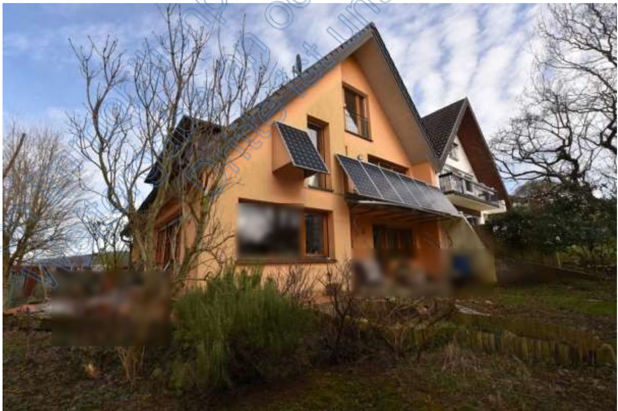
Abb. 34 FlSt. Nr. 773/1, Wohnhaus, Ansicht von Südwesten
