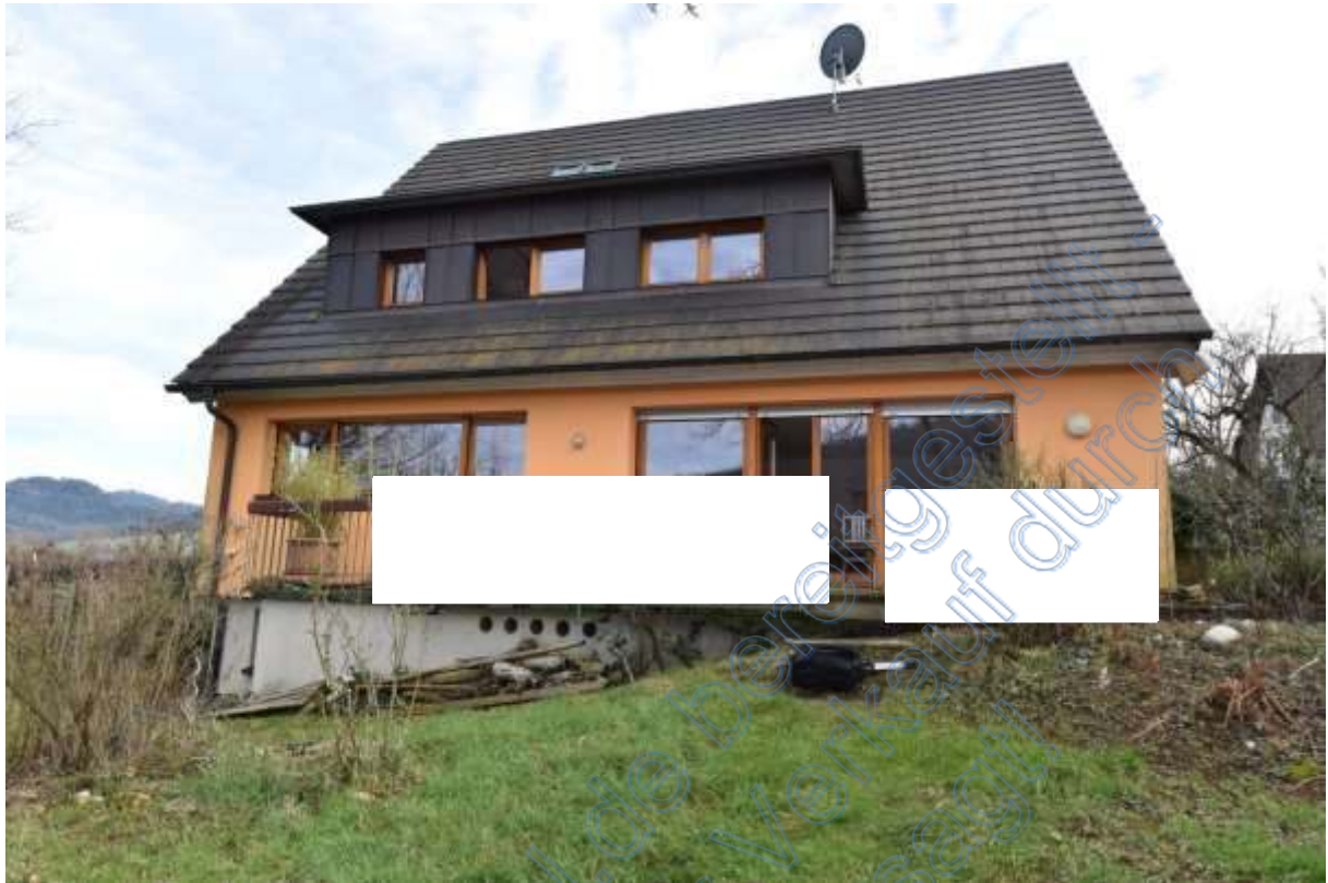
Abb. 33 FlSt. Nr. 773/1, Wohnhaus, Ansicht von Nordwesten
