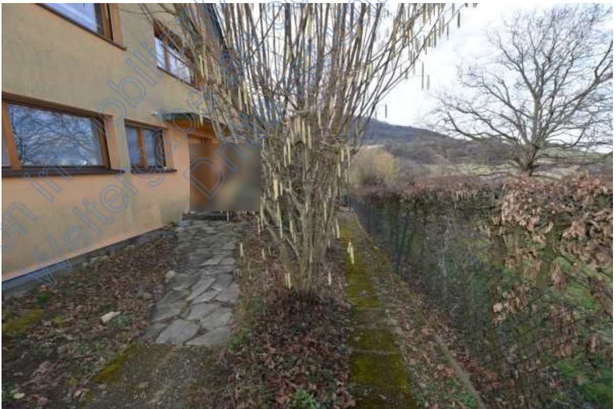
Abb. 38 FlSt. Nr. 773/1, Wohnhaus, Ansicht von Südosten (Hauseingang)
