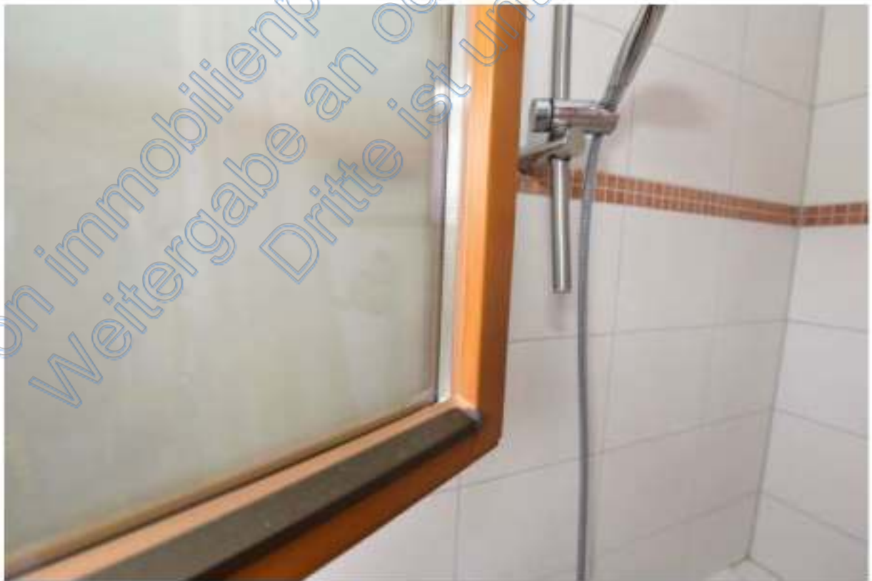
Abb. 74 Dachgeschoss. Bad/WC, Fensterausstattung
