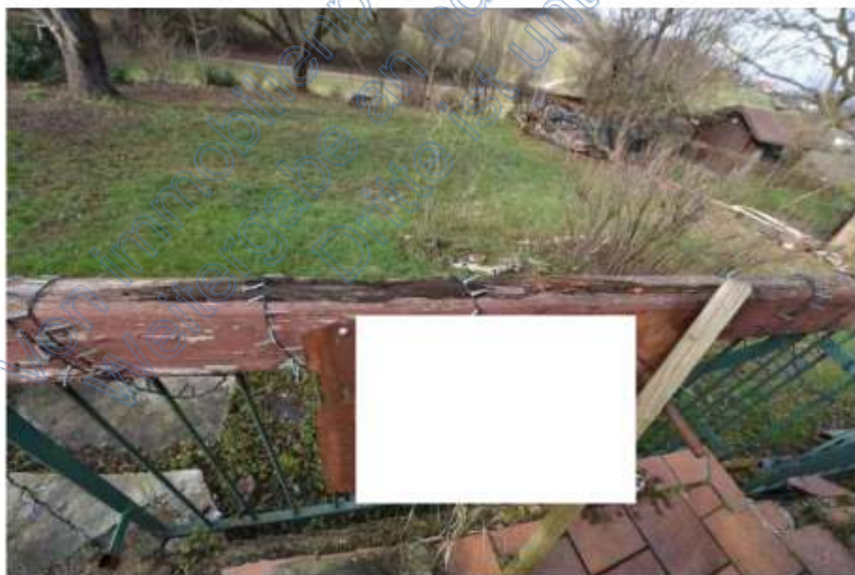
Abb. 56 Erdgeschoss. Terrasse, Gartenansicht
