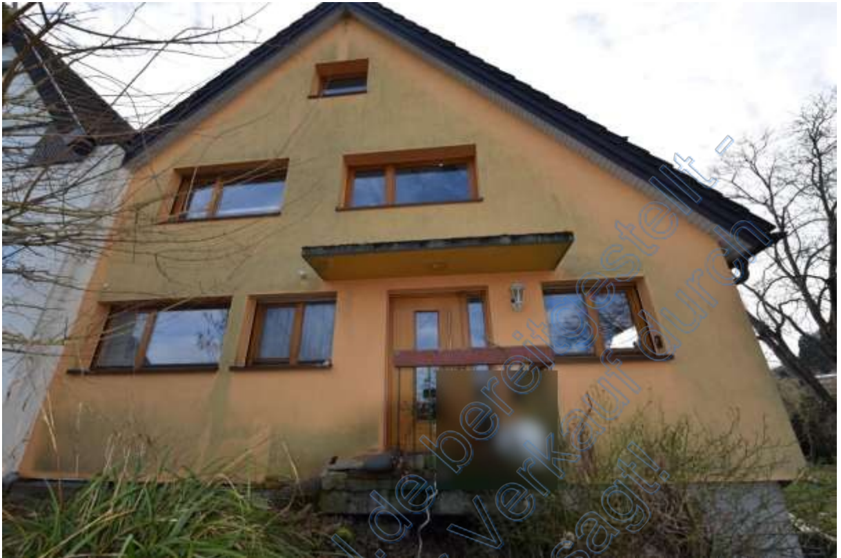
Abb. 37 FlSt. Nr. 773/1, Wohnhaus, Ansicht von Nordosten (Hauseingang)
