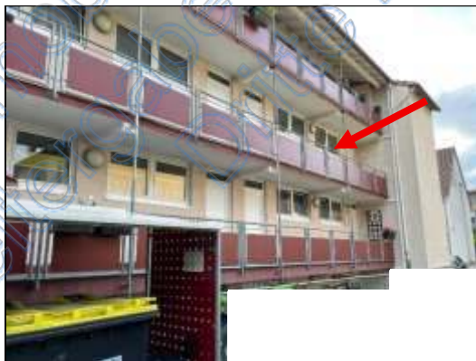
Laubengangerschließung zu den Wohnungen
