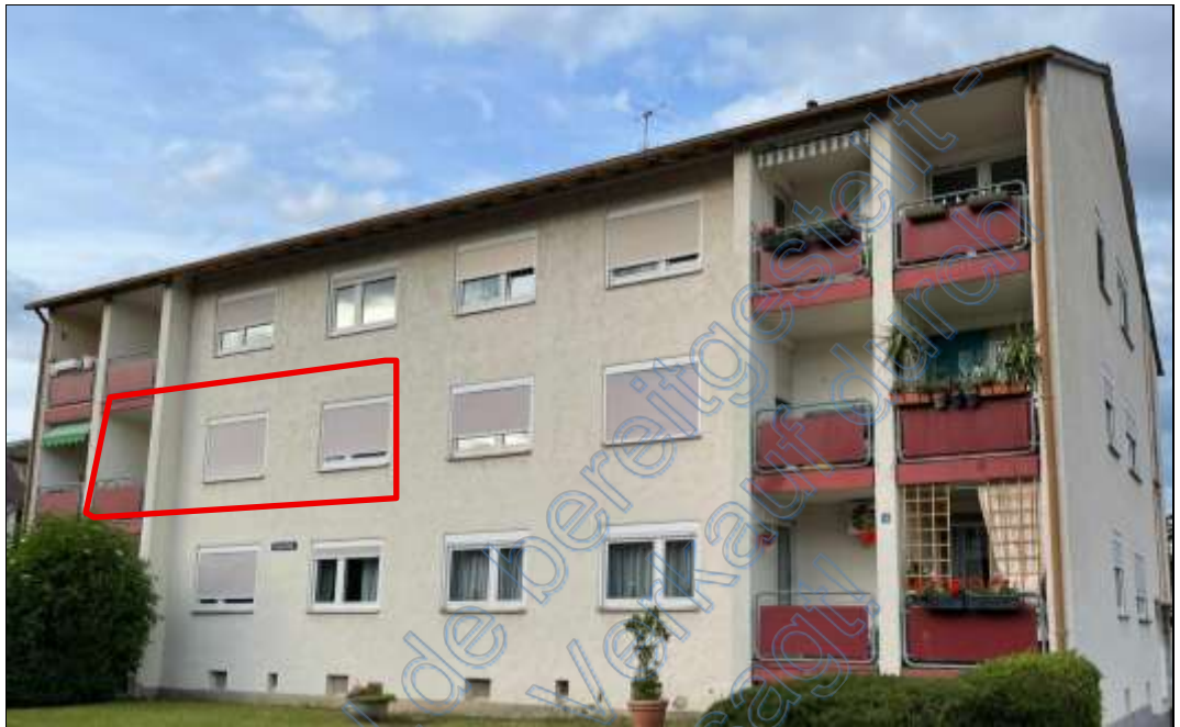
Ansicht von Westen, Lage der Wohnung im 1. OG
