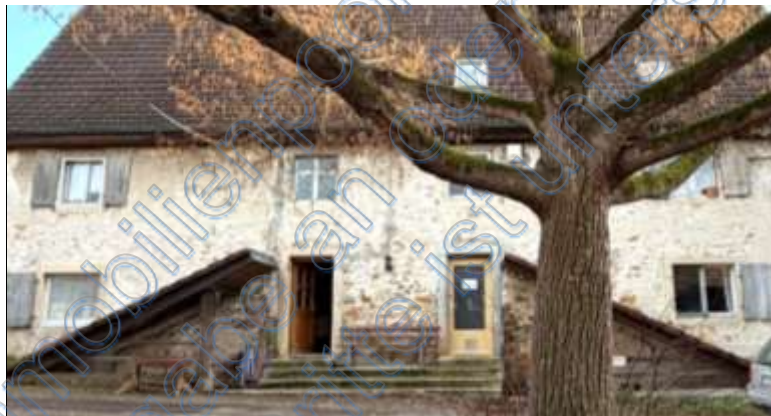
Eingangsseite mit überdachten Kellertreppen
