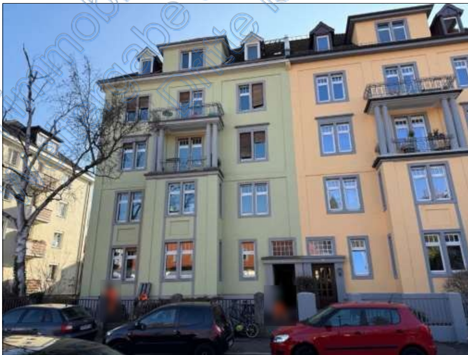
Bild 2: Wohnhaus - Nachbarhaus, Nordfassade
