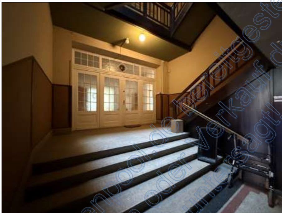
Bild 11: Treppenhaus EG, Wohnungsabschluss
