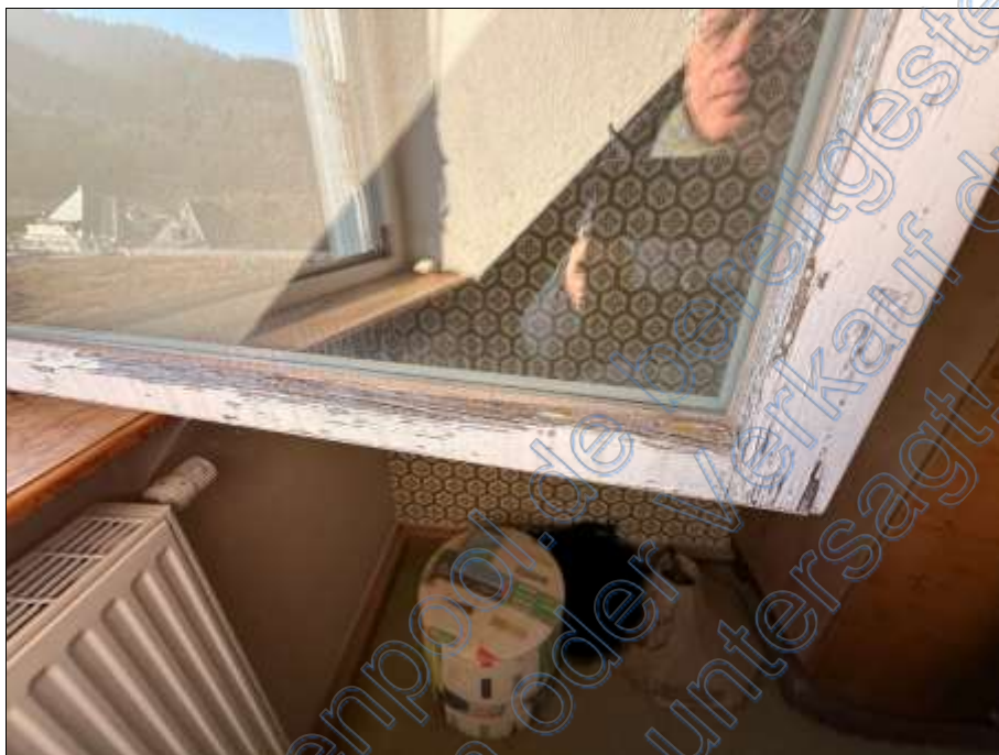
Bild 37: DG, Detail – Holzfenster im Altzustand
