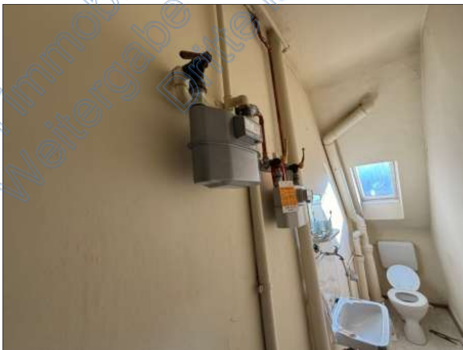
Bild 24: DG, separates WC, Gasinstallation
