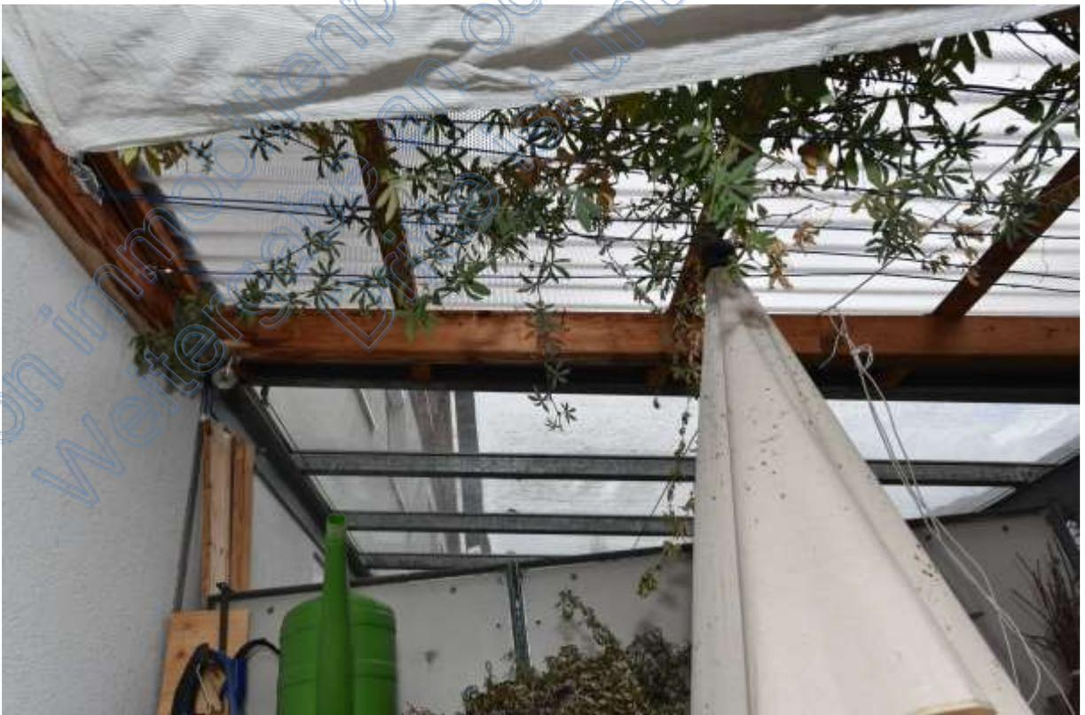
**Abb. 36 Wohnhaus Erdgeschoss: Terrasse, Überdeckung teilweise schadhaft**
