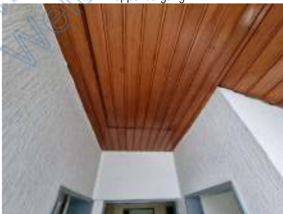
Deckenverkleidung / Zugang Dachboden
