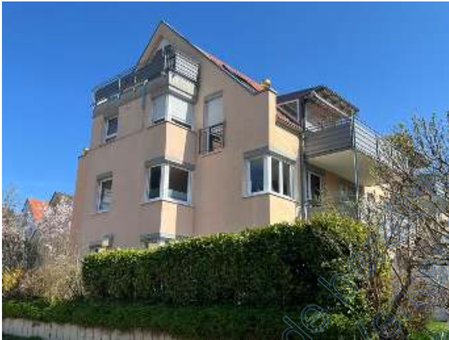
Abbildung 31: Seiten- und Rückansicht hinterer Gebäudeteil
