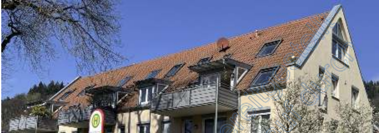
Abbildung 13: Lichtbild mit Außenblick auf die Dachkonstruktion
