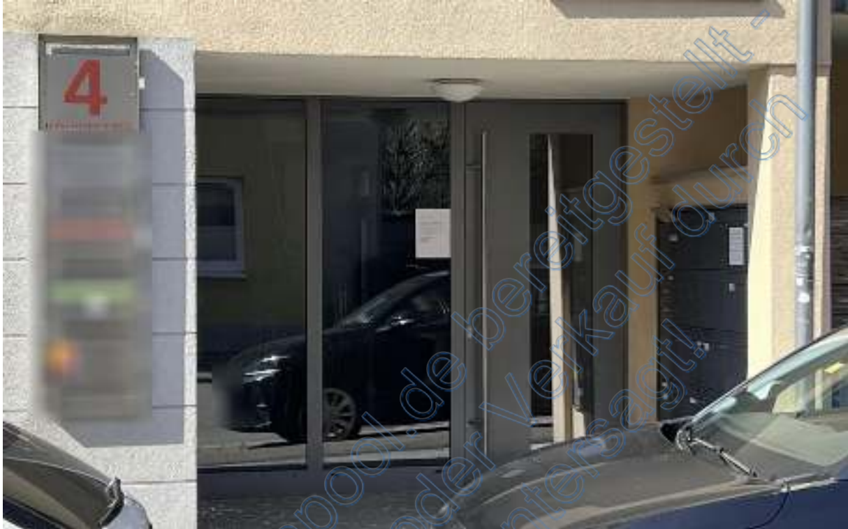
Abbildung 14: Hauseingangsbereich MFH – Hirschenhofweg 4
