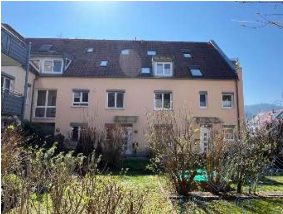
Abbildung 27: Seitenansicht hinterer Gebäudeteil
