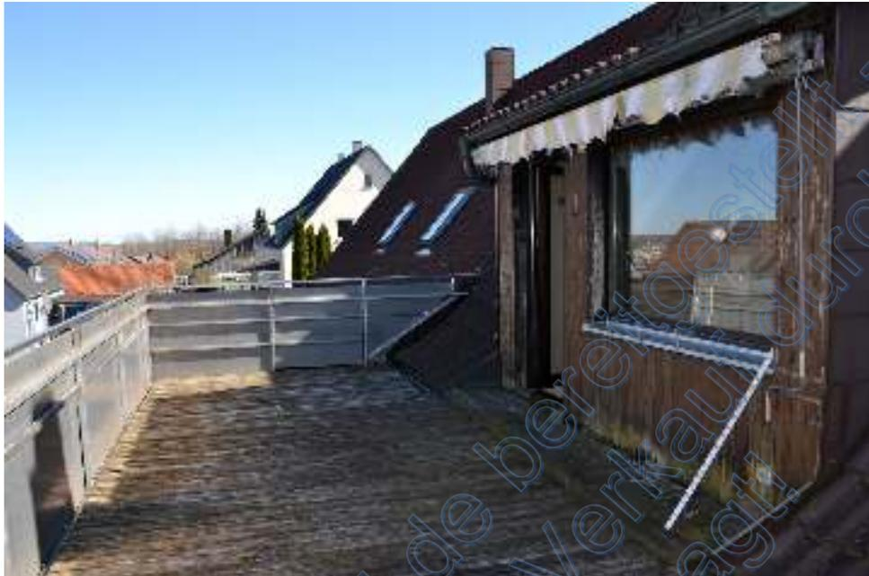
Bild 33: Dachgeschoss Dachterrasse, Holzboden schadhaft
