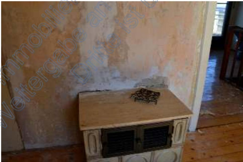
Bild 34: Dachgeschoss Diele, Warmluftauslass des nicht funktionsfähigen Kachelofens.
