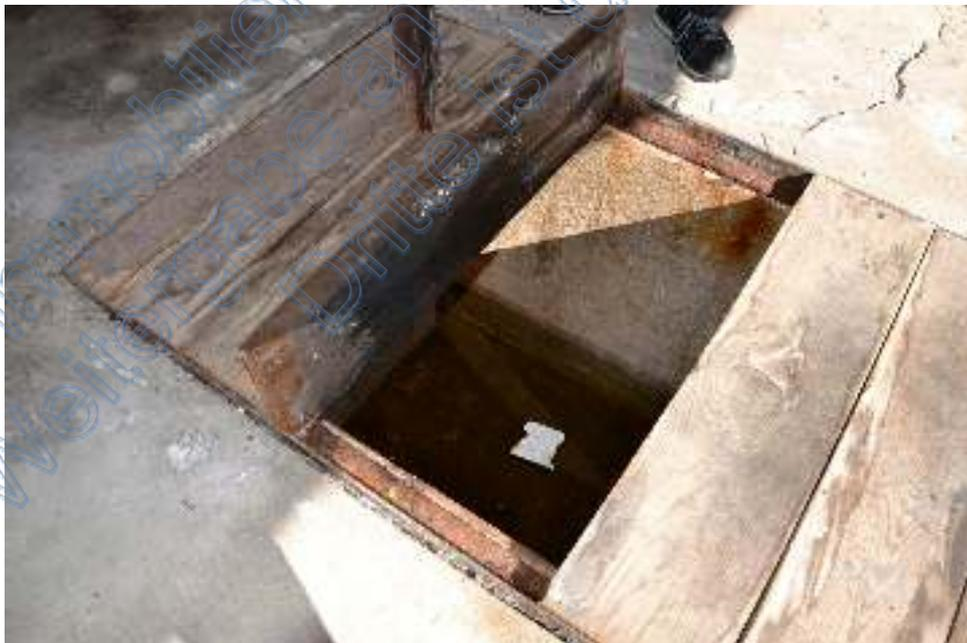
Bild 40: Doppelgarage, Risse, Montagegrube ist mit Wasser vollgelaufen
