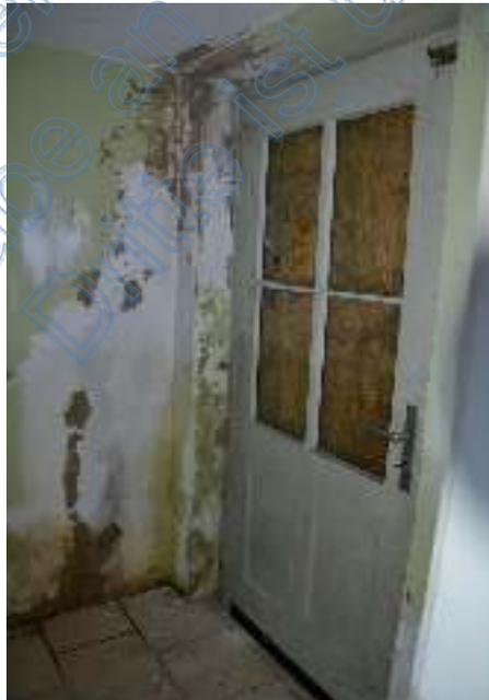
Bild 14: Untergeschoss Kelleraußentüre defekt, Ausblühungen
