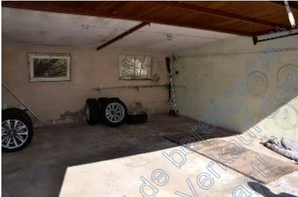
Bild 39: Doppelgarage, Innenbereich, Risse erkennbar am und im Gebäude; Wellasbestdach
