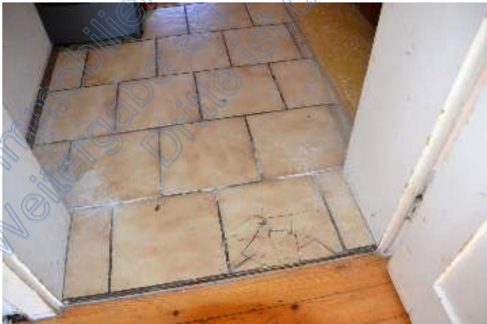
Bild 26: Erdgeschoss, Diele/Flur, defekter Fliesenbelag
