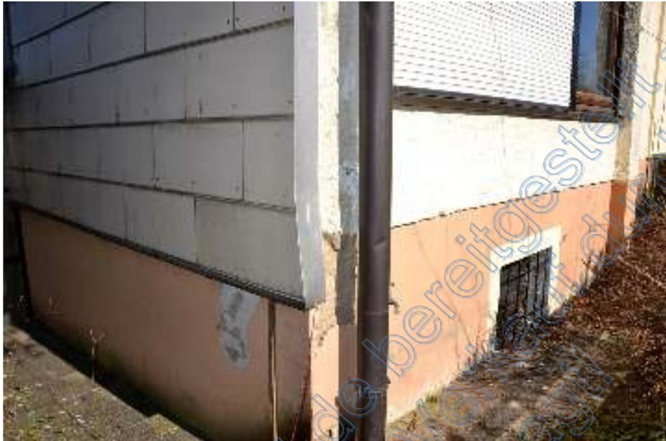
Bild 7: Fassadenverkleidung mit asbesthaltigem Welleternit, mit Schäden
