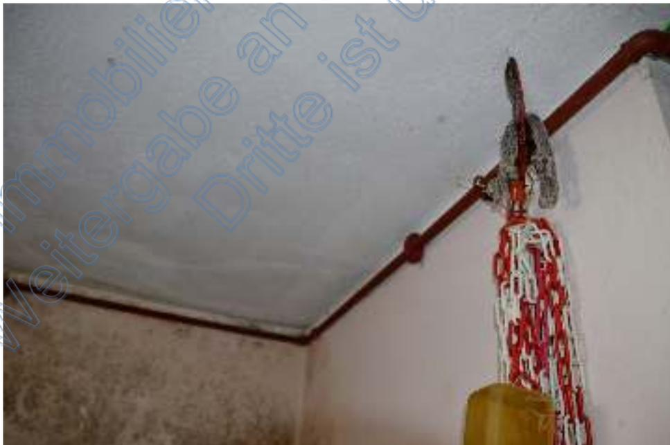
Bild 16: Untergeschoss Keller 1, oxidierte Leitung
