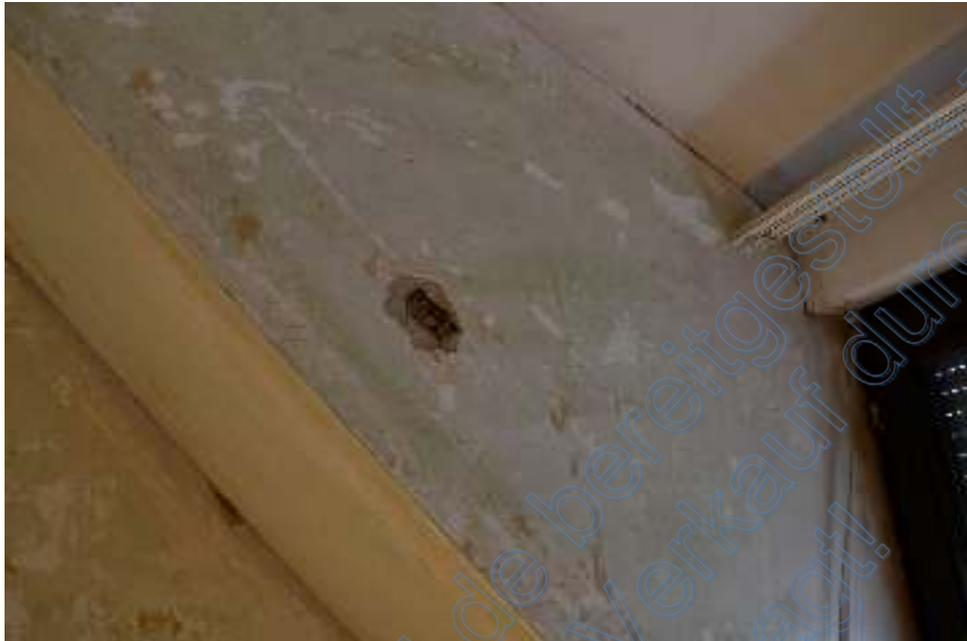
Bild 31: Dachgeschoss Zimmer, Stroheinlagen im Wandaufbau
