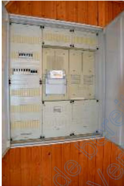
Bild 29: Erdgeschoss ohne FI-Fehlerschutzschalter, elektrische Anlagen sind nicht auf dem aktuellen Stand der Technik
