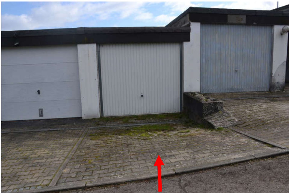
Bild 8: Westansicht der Reihengarage (Pfeil)
