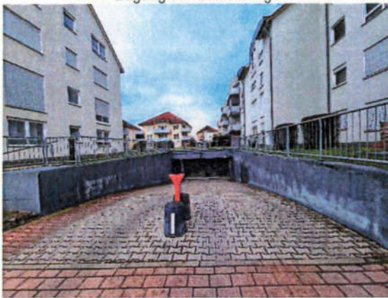
Zufahrt zur Tiefgarage
