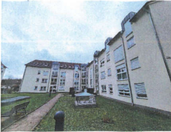
Zugang über die Innenanlage
