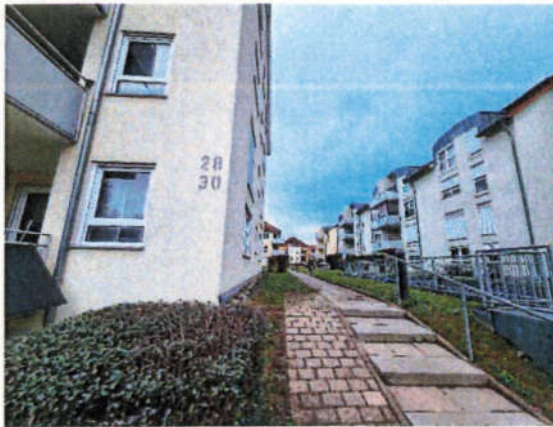
Zugang zur Innenanlage
