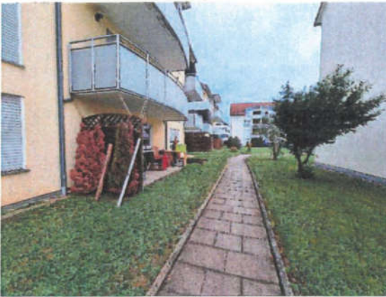
Zugang zur Innenanlage
