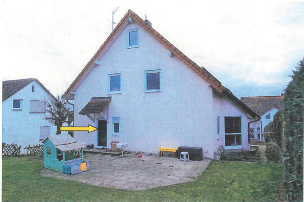
Rückseitiger Blick auf das Bewertungsobjekt von Norden. Der gelbe Pfeil zeigt auf den Gartenzugang durch den Hauswirtschaftsraum.
