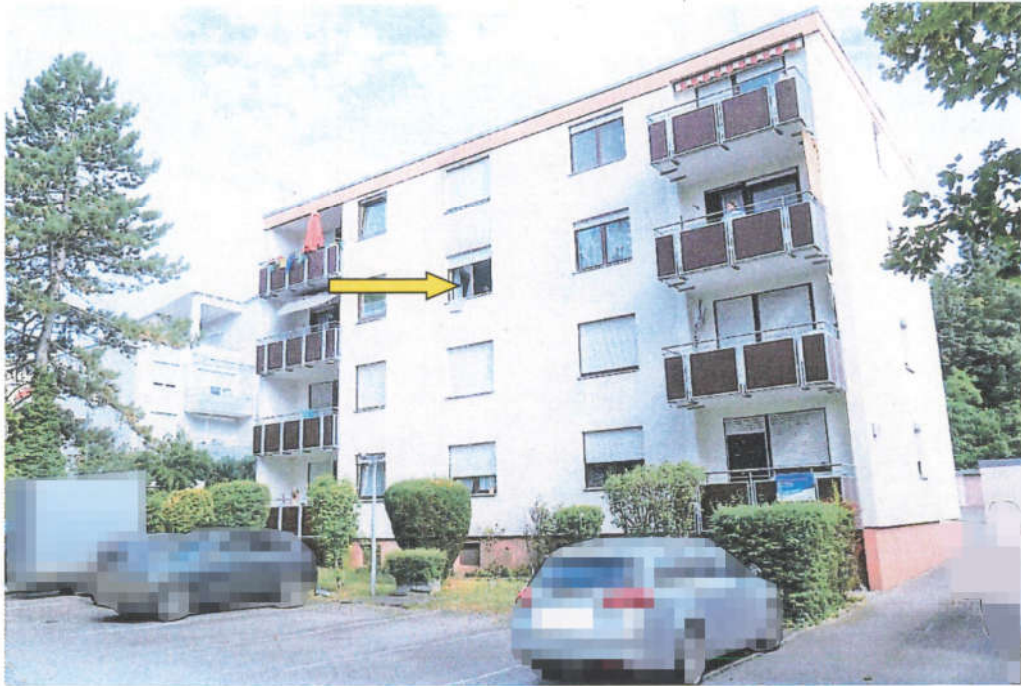
Blick auf die Häusergruppe auf dem Flst. Nr. 2770/2 von Süden aus. Der gelbe Pfeil zeigt auf das Fenster des Wohn-/Schlafzimmers der zu bewertenden Wohnung Nr. 10.
