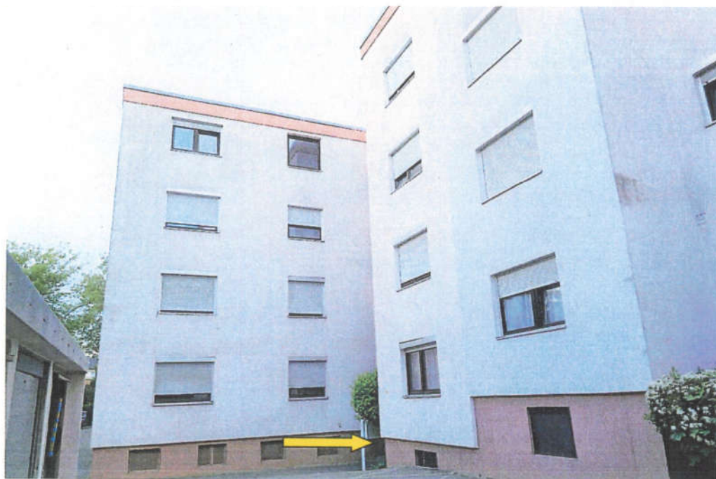
Blick auf das Haus Nr. 210 von Nordosten. Der gelbe Pfeil zeigt den Wohnhauszugang.
