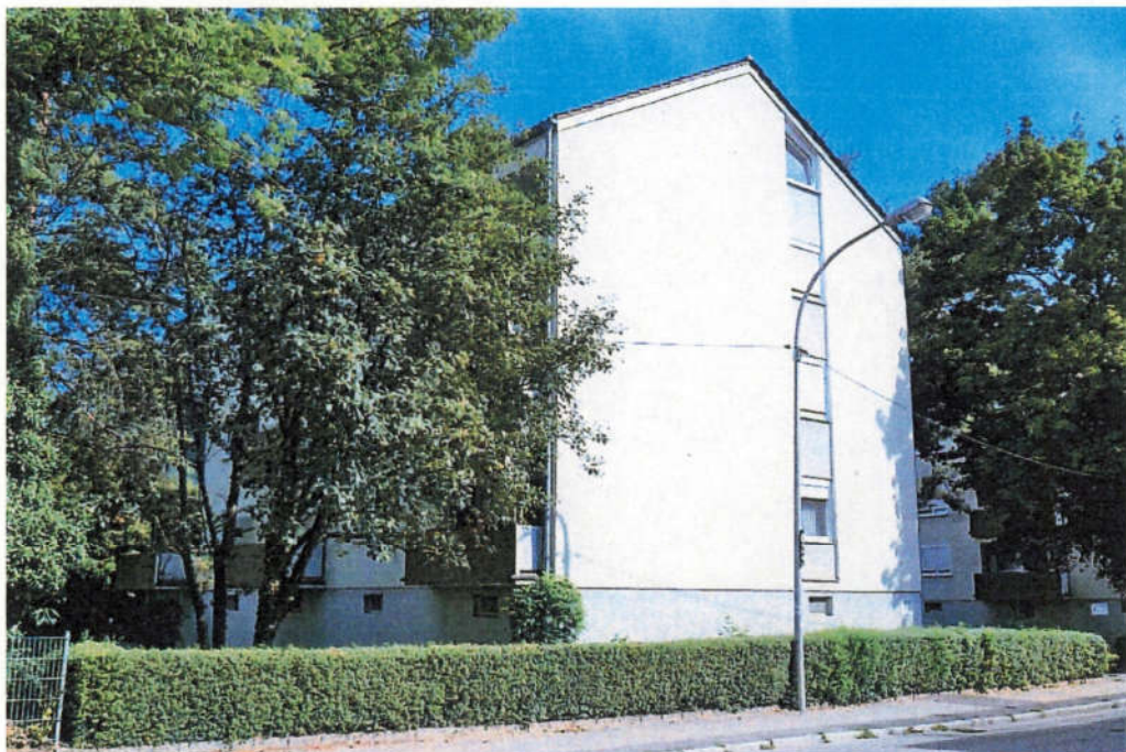
Straßenseitige Ansicht des Wohngebäudes von Süden.
