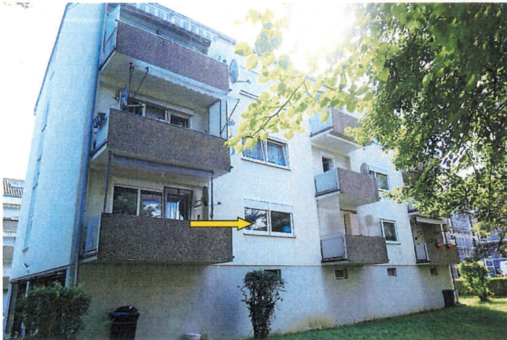
Blick auf das Wohnhaus Nr. 12 von Westen. Der gelbe Pfeil zeigt auf das Fenster des Wohn-/Schlafzimmers der zu bewertende Wohnung Nr. 20. Rechts daneben befindet sich die Küche mit Zugang zum Balkon.
