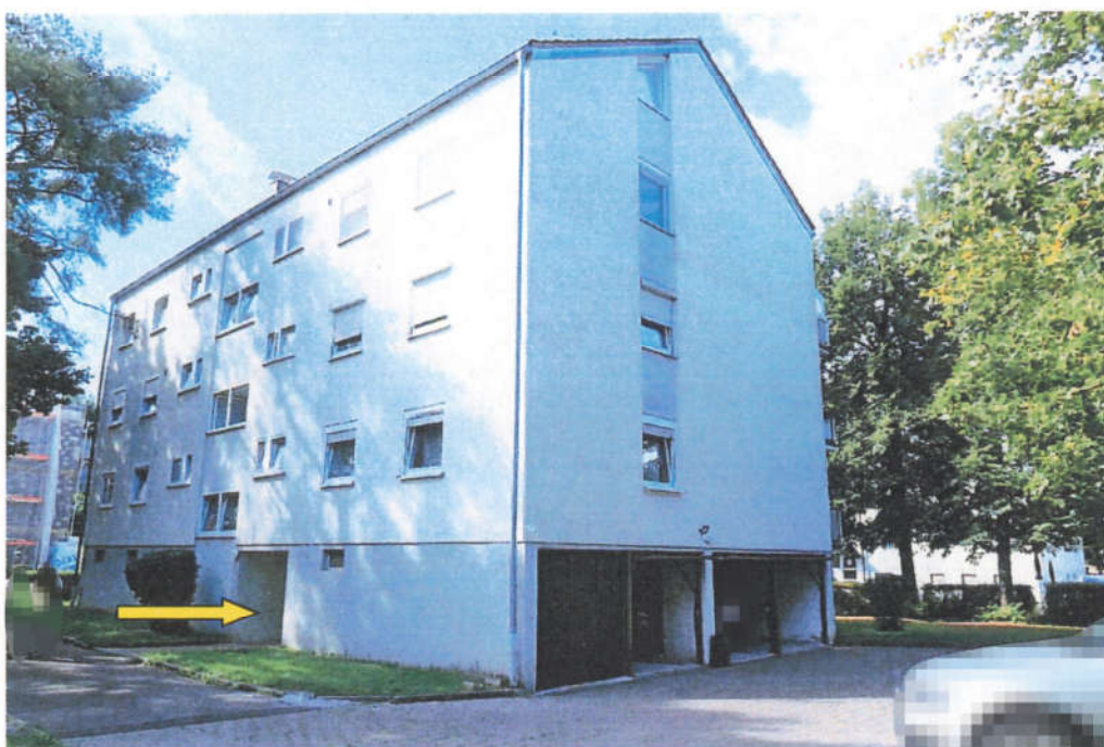
Blick auf das Haus Nr. 12 von Norden. Der gelbe Pfeil zeigt den Wohnhauszugang.
