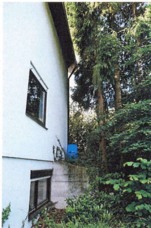
Sicht auf die nordwestliche Gebäudeseite.
