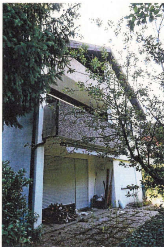
Ansicht der südwestlichen Gebäudeseite.
