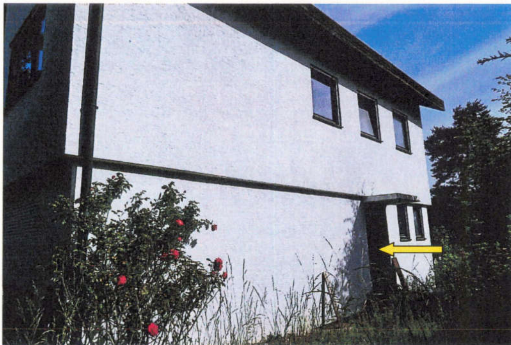
Sicht auf die südöstliche Gebäudeseite mit Wohnhauszugang (gelber Pfeil).
