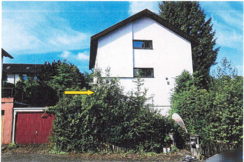
Blick auf das Bewertungsobjekt mit Garage im Vordergrund von Nordosten. Der gelbe Pfeil zeigt auf den Zugang zum Wohnhaus.
