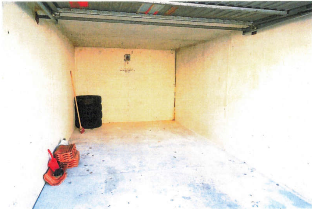
Blick in die rd. 16 m 2 große zu bewertende Fertiggarage.
