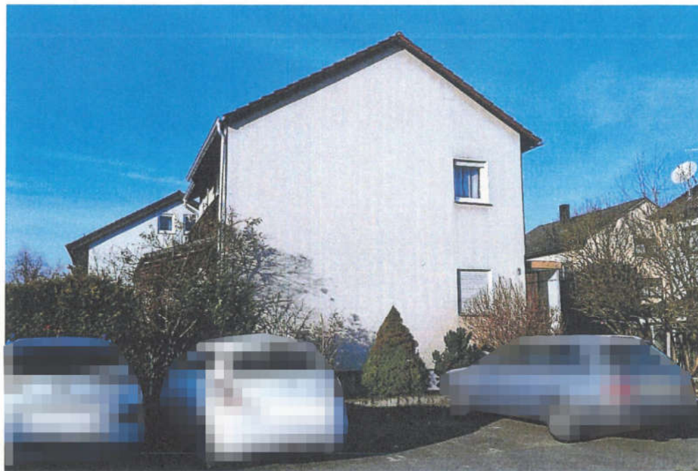
Blick auf das Wohnhaus mit davor liegender öffentlicher Parkfläche von Nord-osten.
