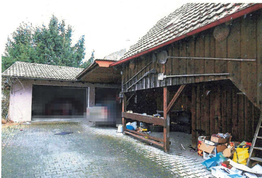
Sicht auf die Doppelgarage mit Schuppengebäude und Verbindungsbau von Osten. Die Tore der Garagen fehlen.
