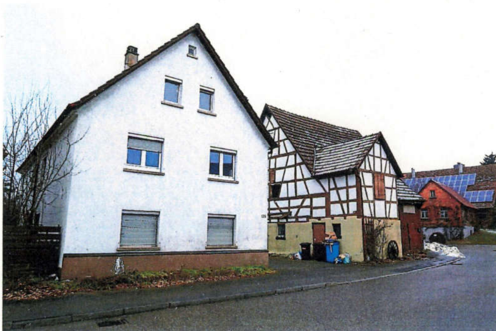
Südostansicht der Bewertungsobjekte. Diese liegen direkt an der K 2129.
