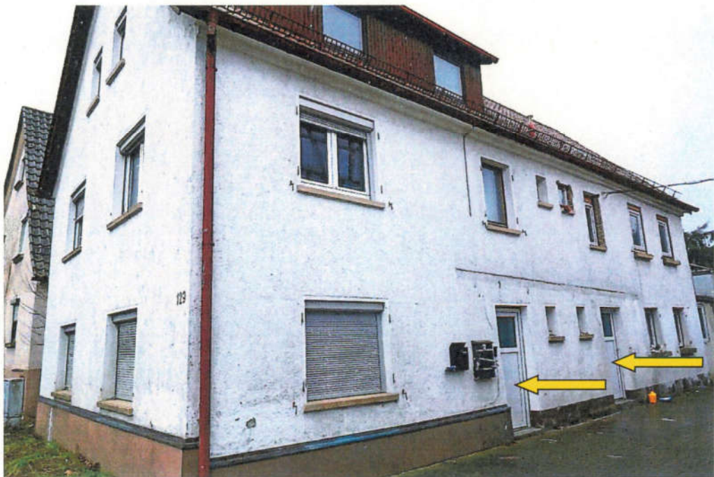
Ansicht des Doppelwohnhauses von Nordosten. Die gelben Pfeile zeigen auf die jeweiligen Hausgänge.
