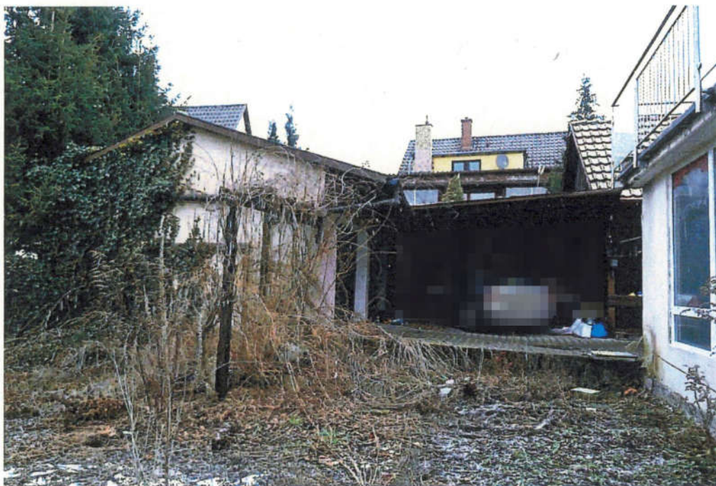
Blick auf die Doppelgarage nebst Verbindungsbau von Süden.
