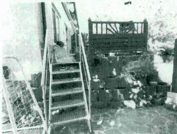
Ansicht Freitreppe zu Terrasse im OG Bild Nr. 5
