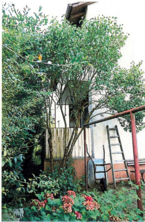
Blick auf die Balkone auf der südlichen Gebäudeseite.
