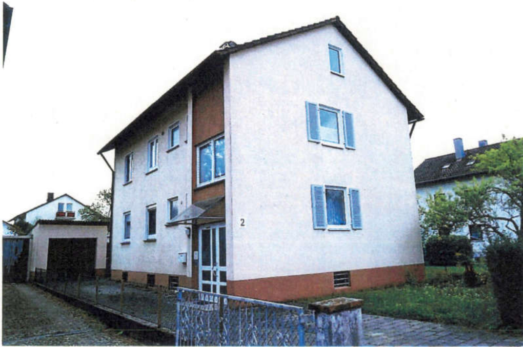
Blick auf das Bewertungsobjekt sowie auf die Garage von Nordwesten.
