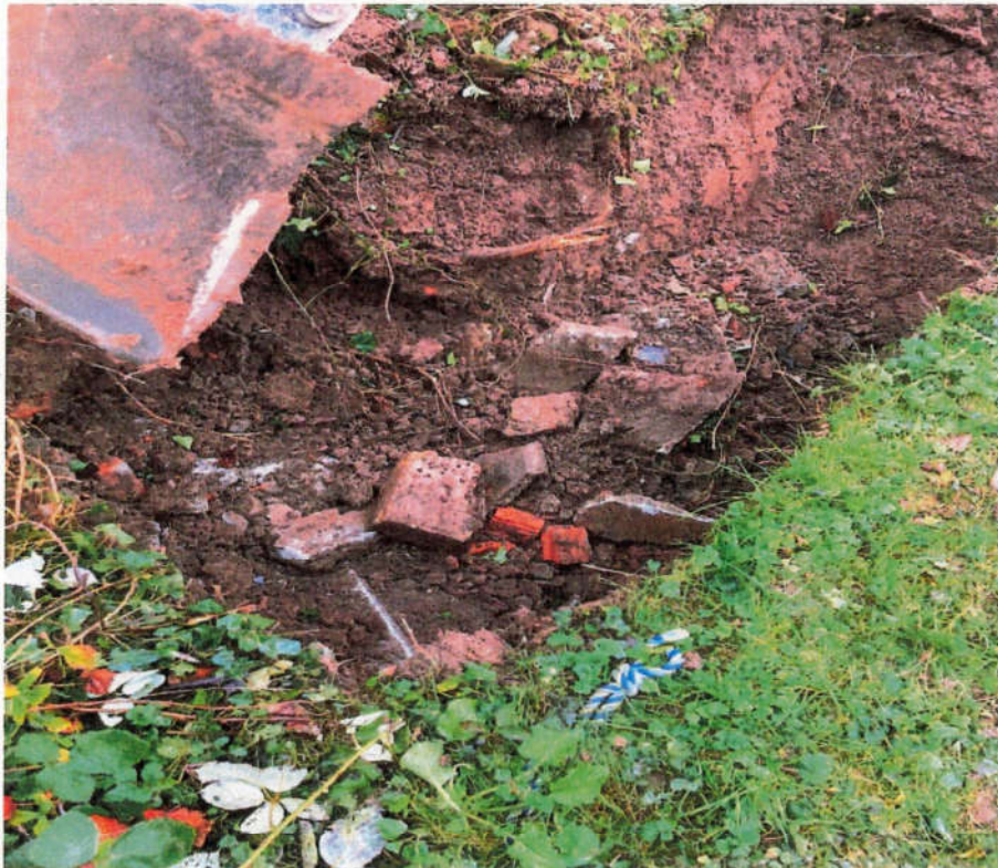
Bild 4: Blick in den Baggerschurf mit Beton- und Ziegelbruch (28.11.2025)
