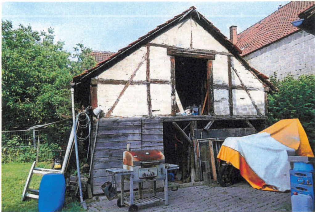
Ansicht des freistehenden Schuppengebäudes.
