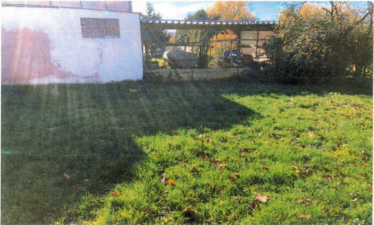
Bild 1: Blick nach Süden auf den Grenzbereich zum Nachbargrundstück; vermutete Altablagerung zwischen linker Glasfensterwand und dem Brombeerbusch rechts (04.11.2025)
