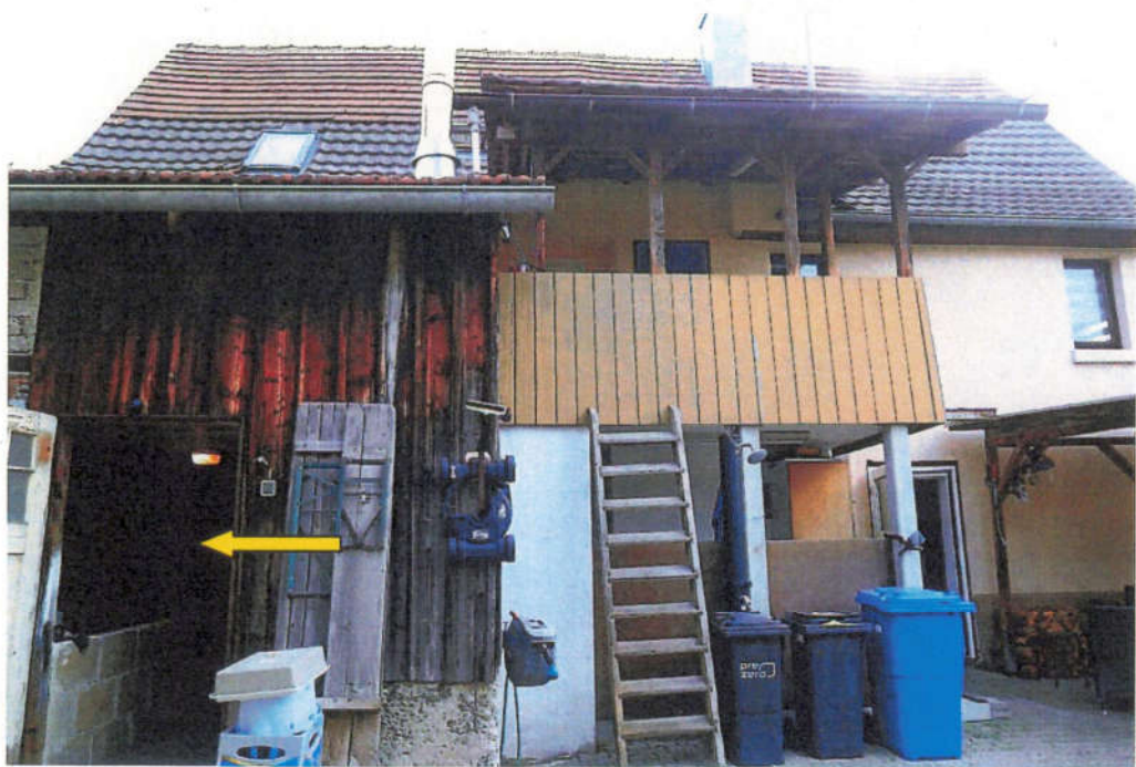
Südwestansicht des Bewertungsobjektes. Der gelbe Pfeil zeigt auf den Zugang zum Gebäudeanbau. In diesem befinden sich die Heizung sowie die Öltanks.
