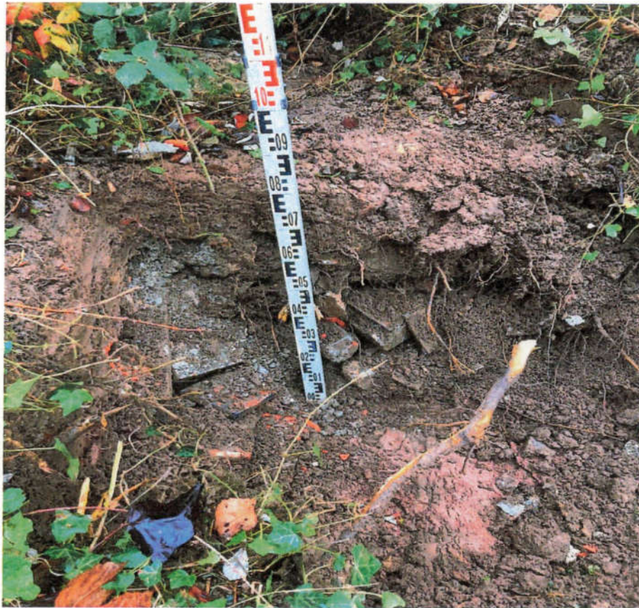
Bild 5: Blick in den Baggerschurf mit Bauschutt bis 0,8 m Tiefe (28.11.2025)
