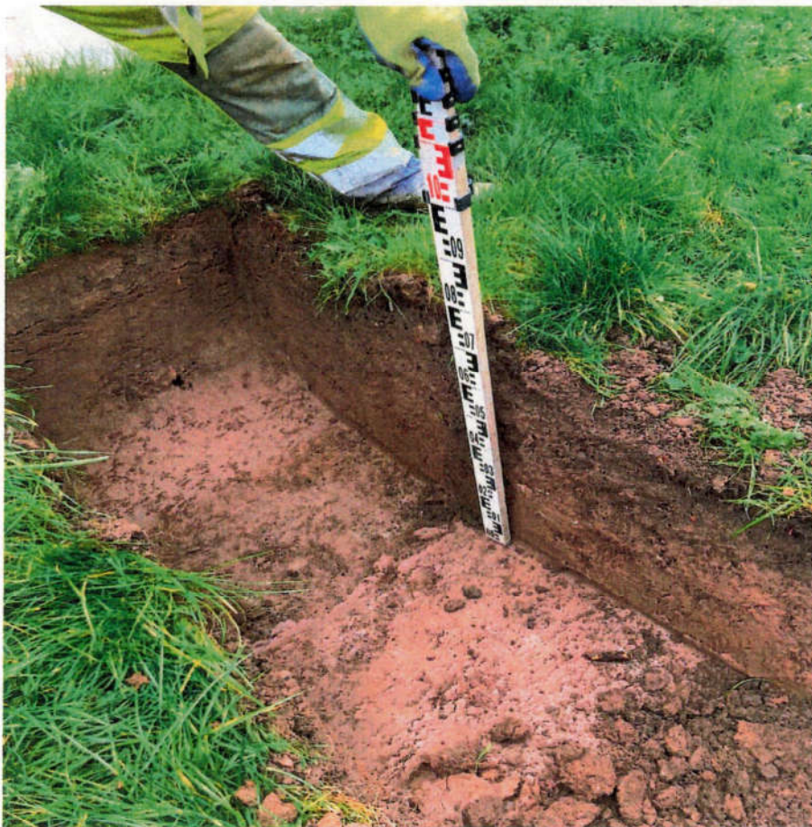
Bild 2: Blick in Baggersuchschlitz nahe abgeplatzter Wandfarbe des Nachbargebäudes (siehe Bild 1) auf Lößlehm Boden bis 0,7 m Tiefe (28.11.2025)
