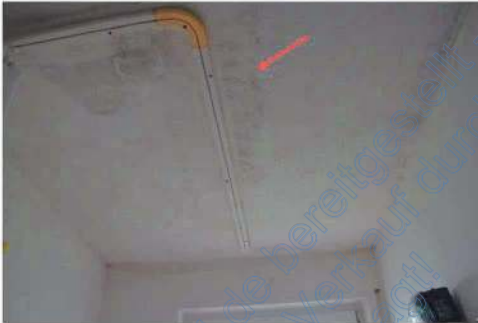
Bild 17: 3. Obergeschoss Bad, Schimmelpilzbefall an Wand/Decke
