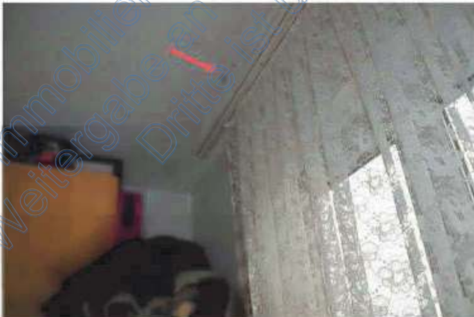
Bild 18: 3. Obergeschoss Schlafzimmer, Schimmelpilzbefall
