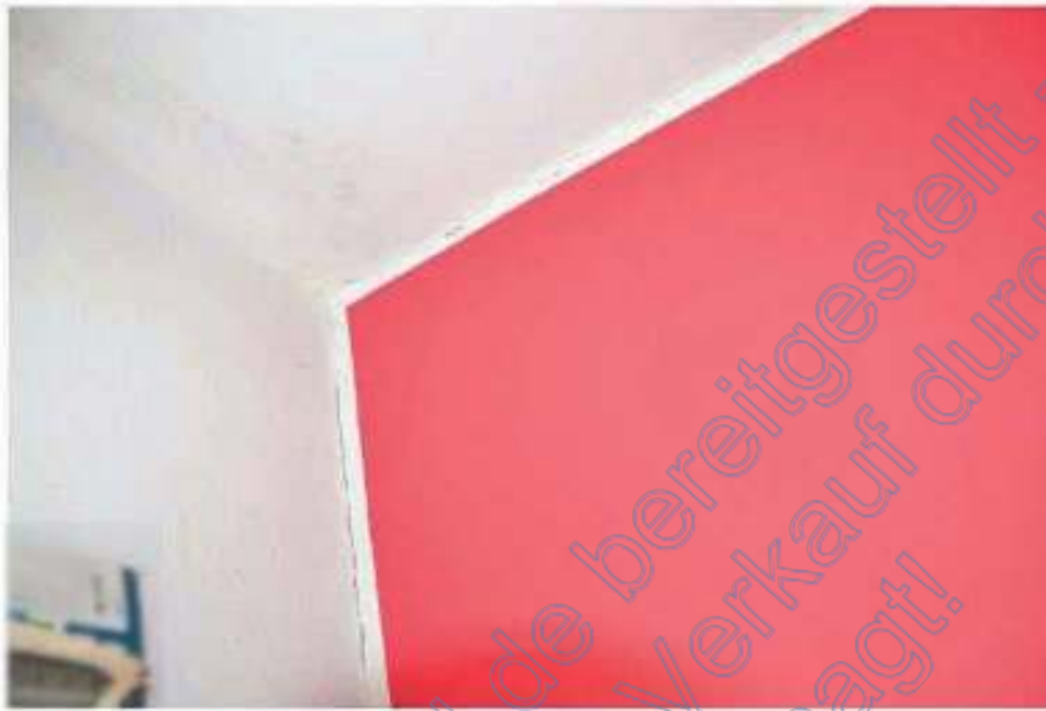
Bild 15: 3. Obergeschoss, Rissbildung an der Decke/Wand
