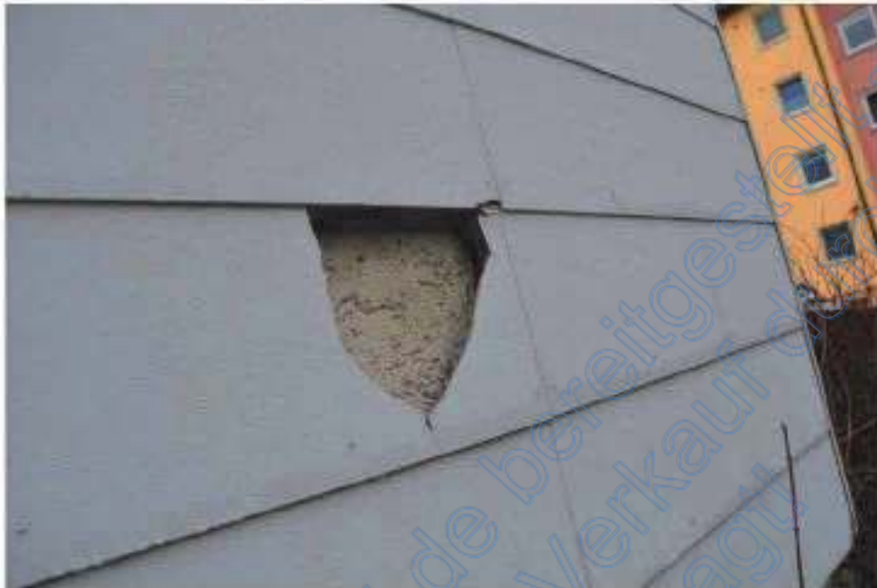
Bild 9: Schäden an der Verkleidung des Westgiebels
