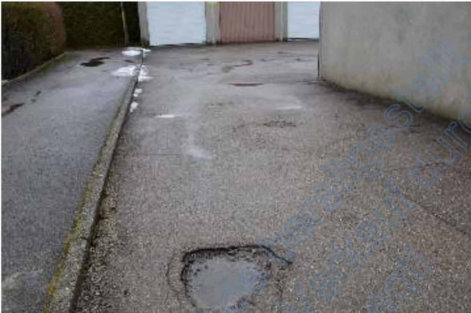
Bild 3: Hofbefestigung und Zufahrt mit Schäden
