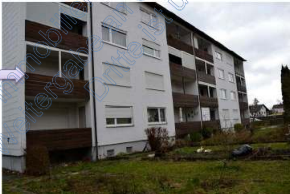
Bild 10: Westansicht 1. Obergeschoss, 1. Balkon von rechts (Bewertungsobjekt Nr. 12)
