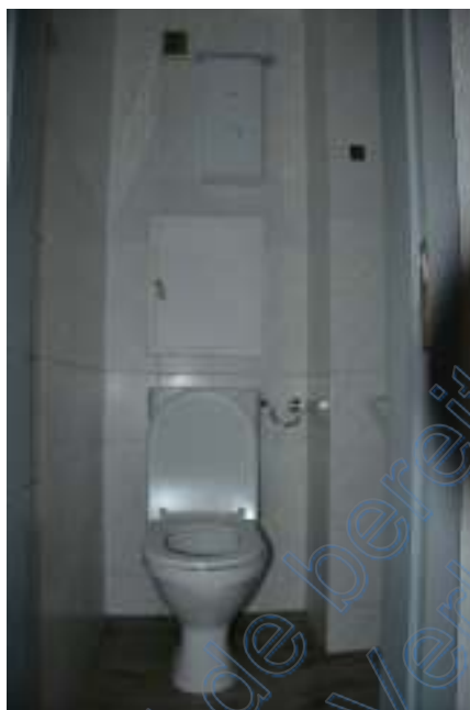
Bild 17: 1. Obergeschoss WC, innenliegend
