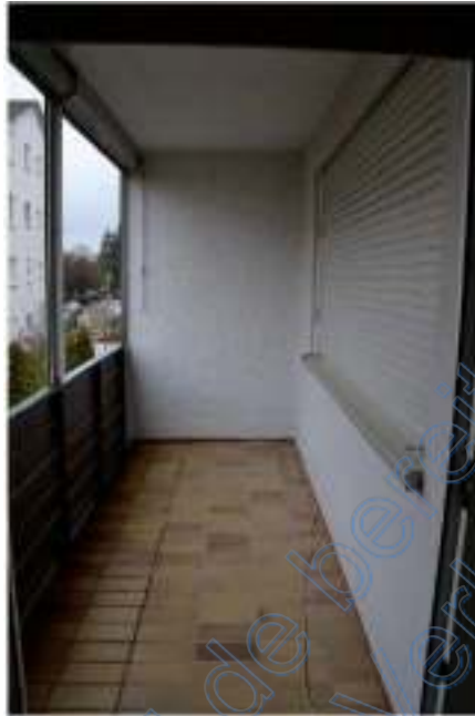
Bild 23: 1. Obergeschoss Loggia Wohnung 12
