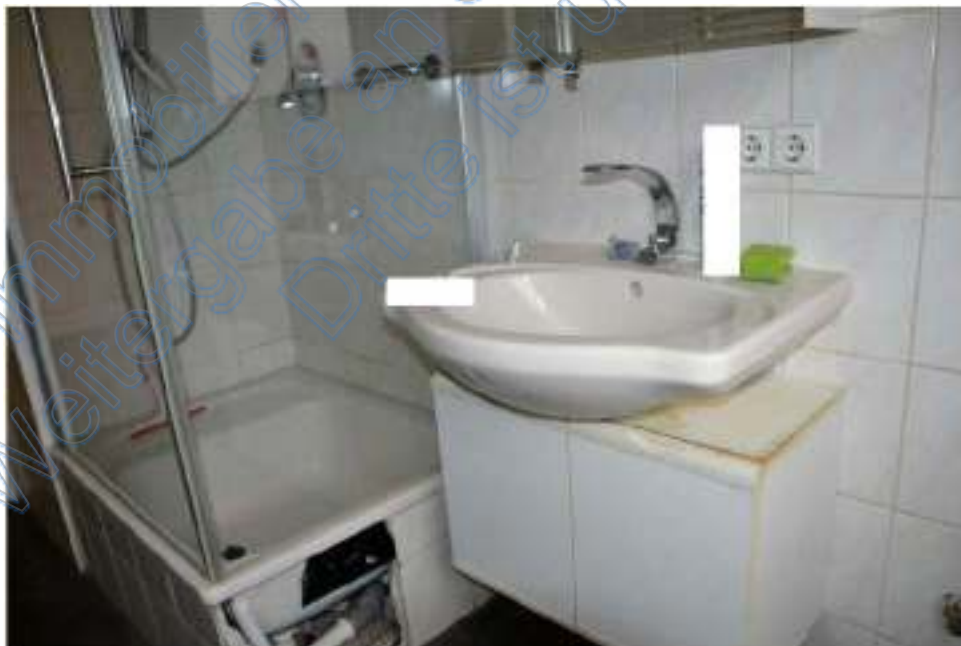
Bild 22: 1. Obergeschoss Bad mit Dusche und Handwaschbecken, defekte Duschwannenverkleidung
