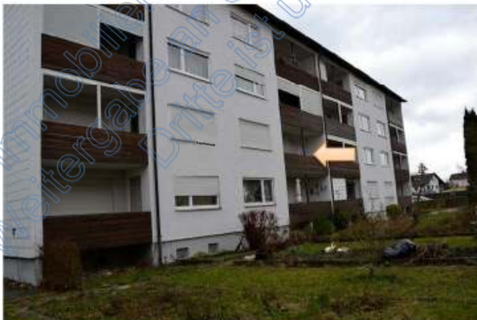
Bild 10: Westansicht 1. Obergeschoss, 2. Balkon von rechts (Bewertungsobjekt Nr. 11)
