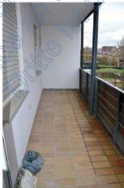
Bild 26: 1. Obergeschoss Loggia Süd Wohnung Nr. 11
