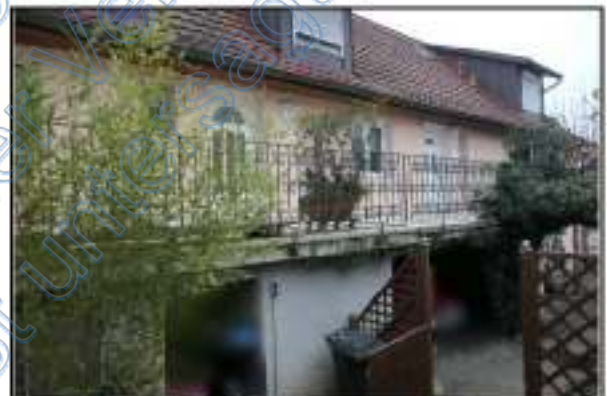
Hofansicht mit Eingangsterrasse von Osten
