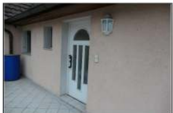
Zugang ETW Nr. 1, WC- und Küchenfenster
