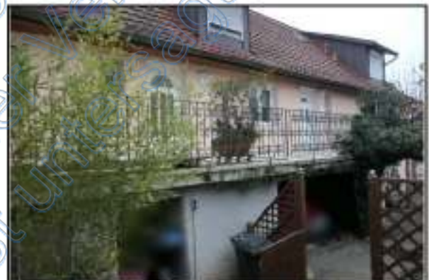
Hofansicht mit Eingangsterrasse von Osten
