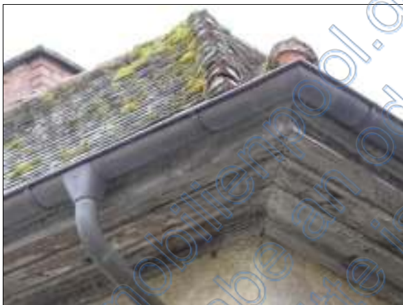
Zustand Dach, Traufgesims
