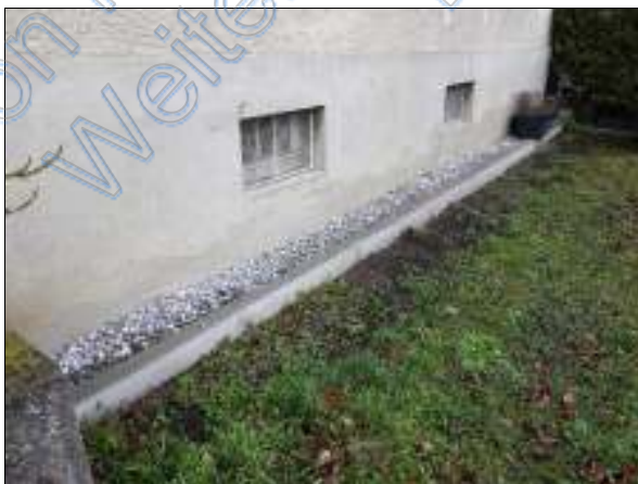
Gebäudesockel mit Geländeanschluss Süd
