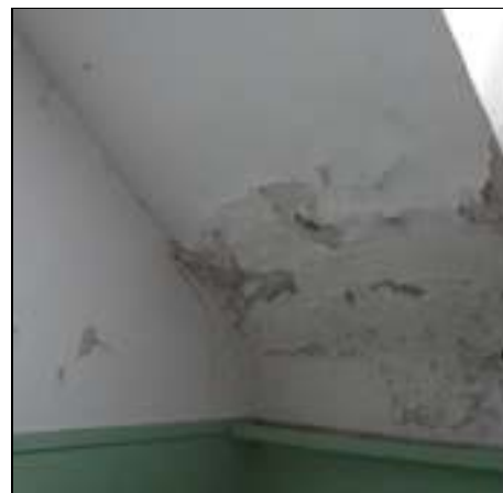
Wasserschaden Gaubeninnenseite
