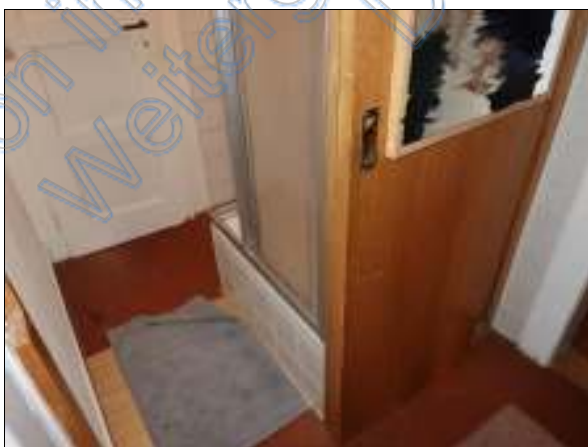
Whg. EG rechts Dusche im Vorraum WC
