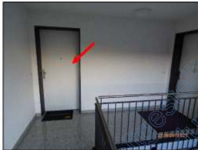
Ansicht: 3 OG Wohnung 26 II-14 (Bild 10)
