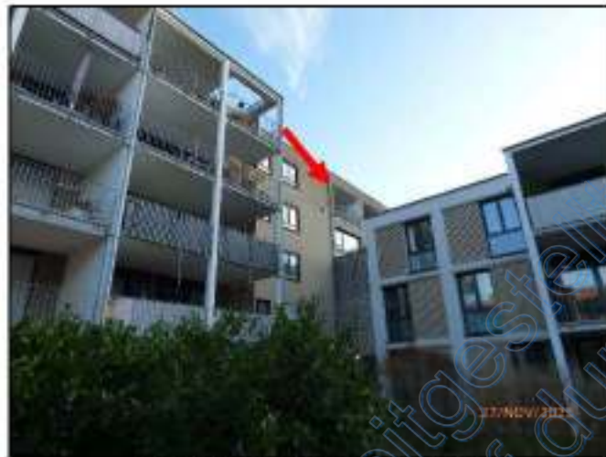
Ansicht: Westseite (Bild 4)
