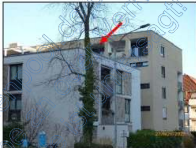
Ansicht: Südwestseite (Bild 5)
