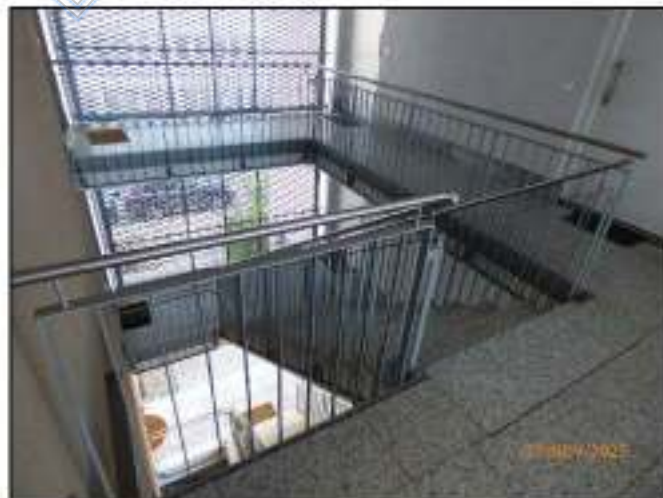
Ansicht: Treppenhaus (Bild 9)
