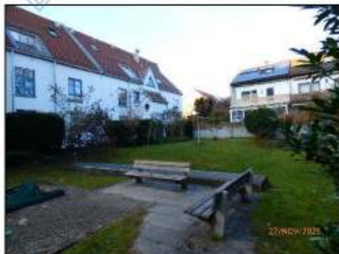
Ansicht: Überdachte Tiefgarage, Hinterhof (Bild 6)
