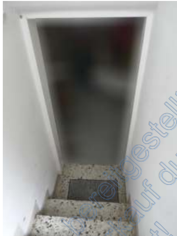
Bild 5: Abgang zur Küche der Wohneinheit Nr.5
