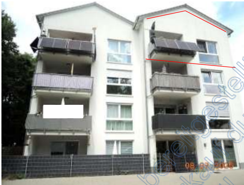
Bild 1: Hofansicht aus südlicher Richtung
